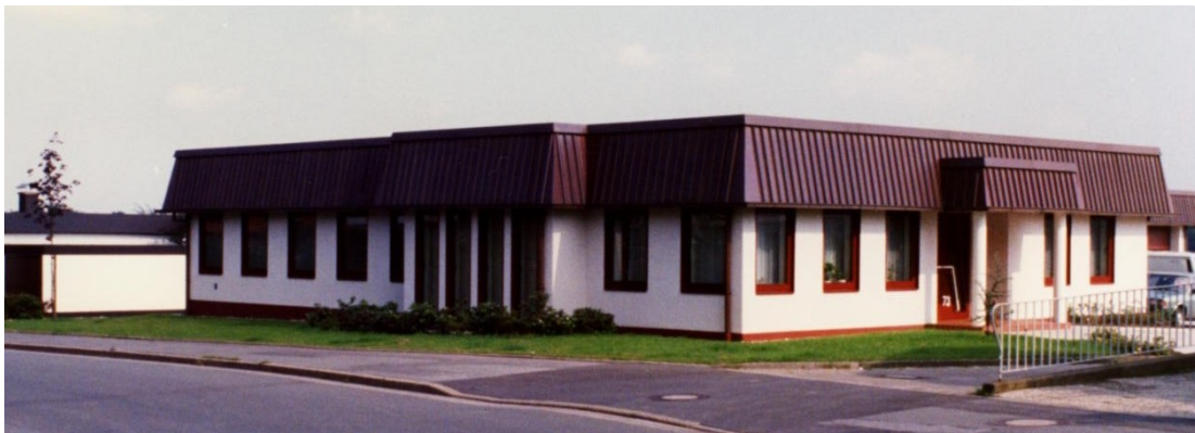
Abb. 12.1 : VEW-Regionalzentrum Brechten, Hauptansicht, Foto: W. Wagner
