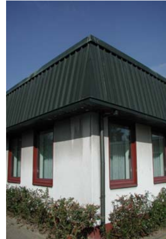
Abb. 11.14: VEW-Regionalzentrum Brechten: Attikaelement der Fa. Kabelmetal mit Sole-Mittel-Flussrohrbahnen als Absorberelement und Kaldachblende. Foto: W. Wagner
