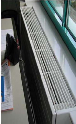
Abb. 11.3: VEW-Regionalzentrum Wambel, Zulufteinheit mit Radiator, (unmaßstäblich), VEW AG, BD/DO, Abt. Bautechnik
