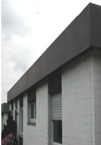
Abb. 11.12: Standardisierte Attikablende eines Kaldaches mit einer Eternit-Verblendung in verschraubter Ausführung, in Dortmund. Foto: W. Wagner
