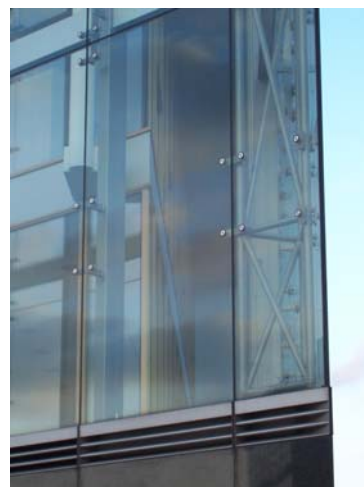
Abb. 6.2: Stadttor Düsseldorf, Fassadenausschnitt an einer Gebäudeecke, Glasaußenhaut-Trägersystem und Innengebäude; Foto: W. Wagner
