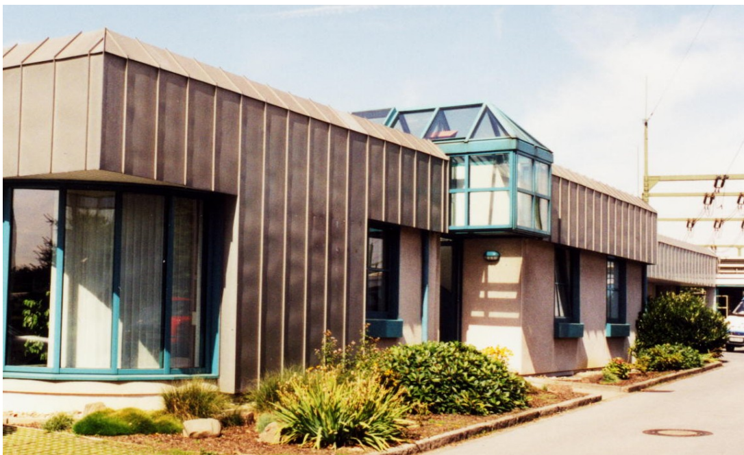
Abb. 12.2: VEW-Regionalzentrum Wambel, Haupteingang. Foto: W. Wagner
