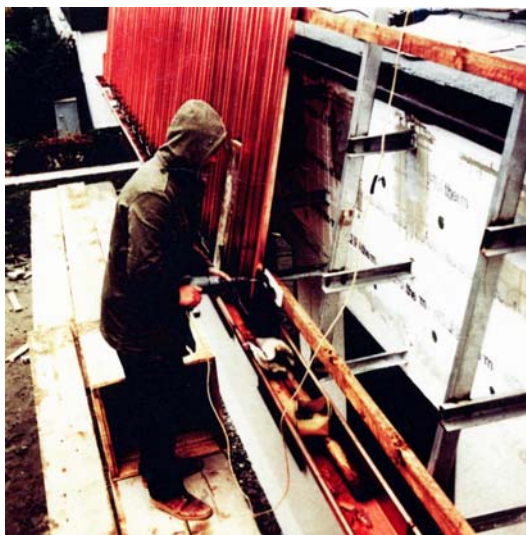
Abb. 9.8: VEW-Regionalzentrum Brechten, Montage der Attika-Konstruktion, Phase 1. VEW AG, BD/DO, Abt. Bautechnik
