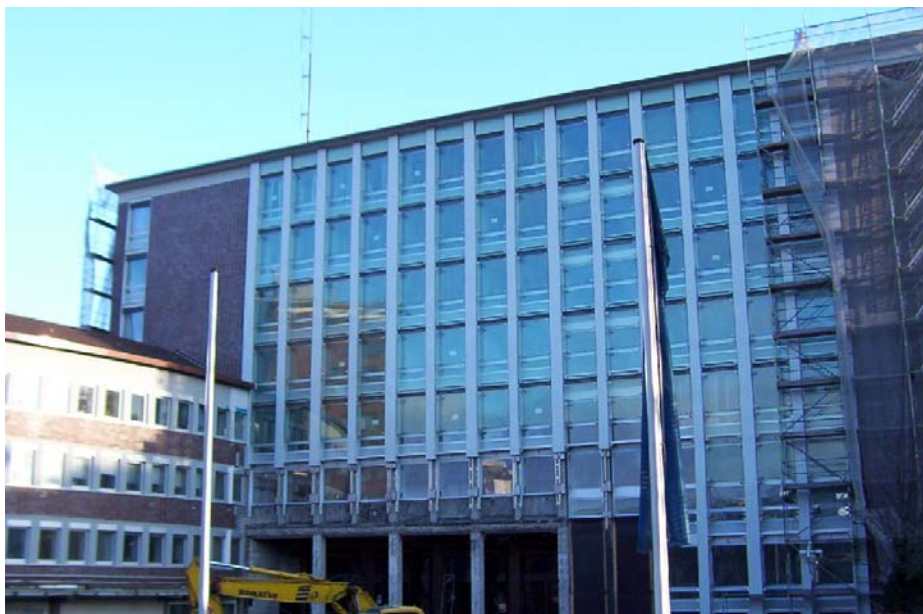
Abb. 7.2: DEW-Hauptverwaltung, Bauteil Turm, (nach der Sanierung), Foto: W. Wagner
