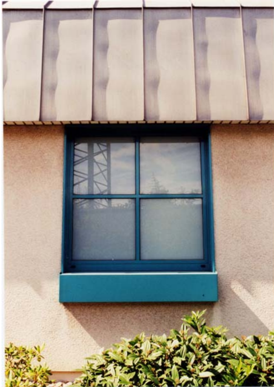
Abb. 11.15: VEW-Regionalzentrum Wambel: Fensterelement mit Zulufffensterbankkasten. Foto: W. Wagner
