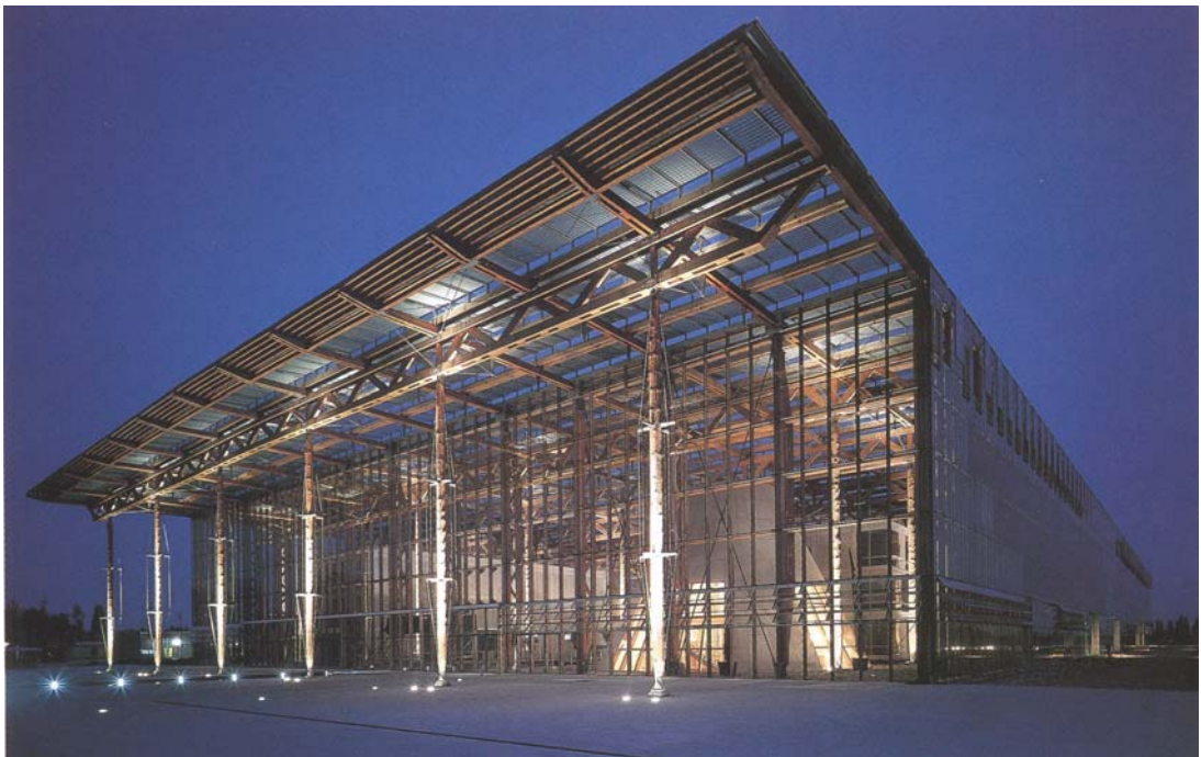
Abb. 5.1: Akademie Mont Cenis in Herne-Sodingen, Ansicht des Haupteingangs, aus: Hawkes / Forster, S. 101
