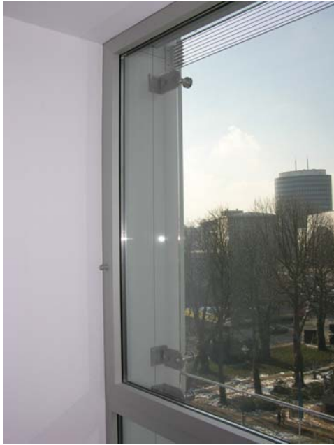
Abb. 7.6: Innenaufnahme des Parallel-Aufstell-Dreh-Fensters (PAD-Fenster) sowie des außen liegenden Drehflügels. Foto: W. Wagner
