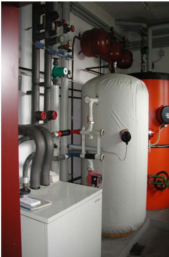
Abb. 10.1: VEW-Regionalzentrum Brechten, EWP, Solespeicher, Pufferspeicher (von links); (s. auch Abb. 10.2), Foto: W. Wagner
