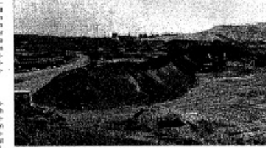
... nach rascher Sanierungsarbeiten und Anweisung mit Konzept hochwertiger Oberböden.
