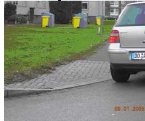
Abbildung 10: Bordsteinabsenkungen am Schäffleweg
