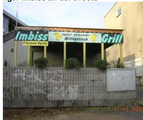
Abbildung 19: Leer stehender ehemaliger Imbiss an der Droote
