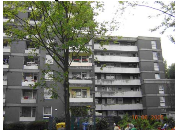
Abbildung 27: sanierungsbedürftige Fassade am Baaderweg
