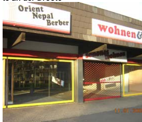
Abbildung 17: Leerstehende Geschäfte an der Droote
