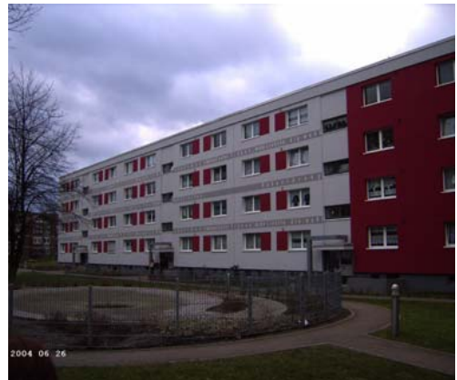
Abbildung 5: Mit „gut“ bewertete sanierte Fassade
