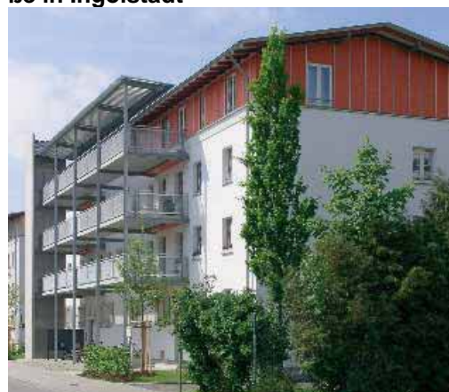
Abbildung 28: Nachträglicher Anbau eines Aufzuges in der Hindemithstraße in Ingolstadt
