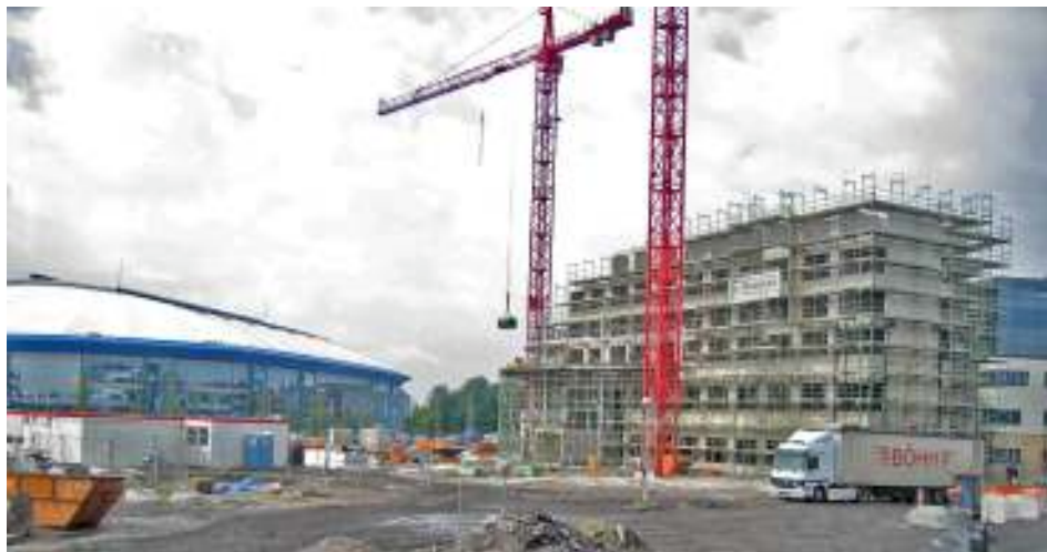
Abbildung 6.1: Ansicht von Nord-Ost
