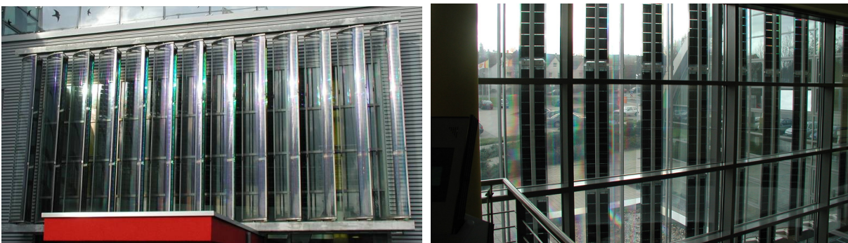
Bild 118: Prototyp-Anlage mit gebogenen Lamellen a) Außenansicht, b) Innenansicht
