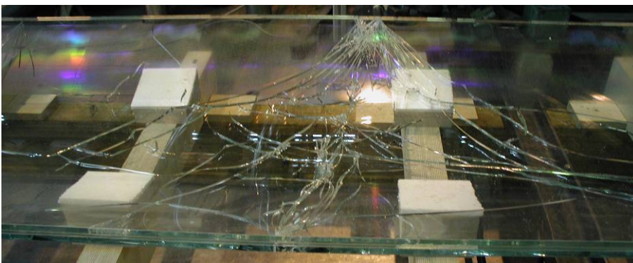
Bild 121: Rissbild mit Rissursprung am Scheibenrand
