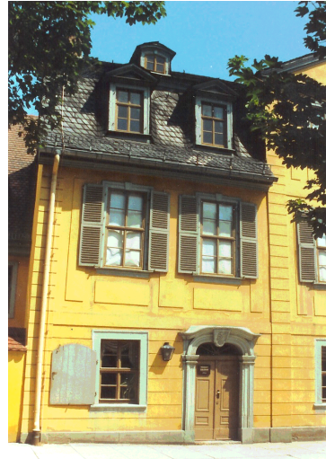
ABB. 7: SCHILLERHAUS (eig. Aufnahmen 1989)
