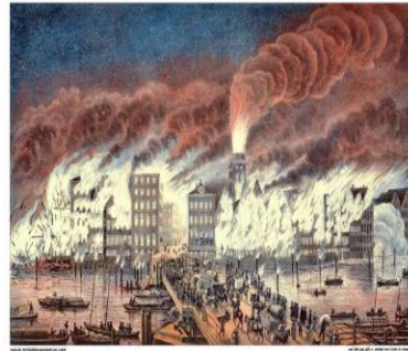
Der Brand der Nicolai-Kirche in der Nacht vom 5 ten auf den 6 ten Mai 1842, von der Hofbrücke gesehen
