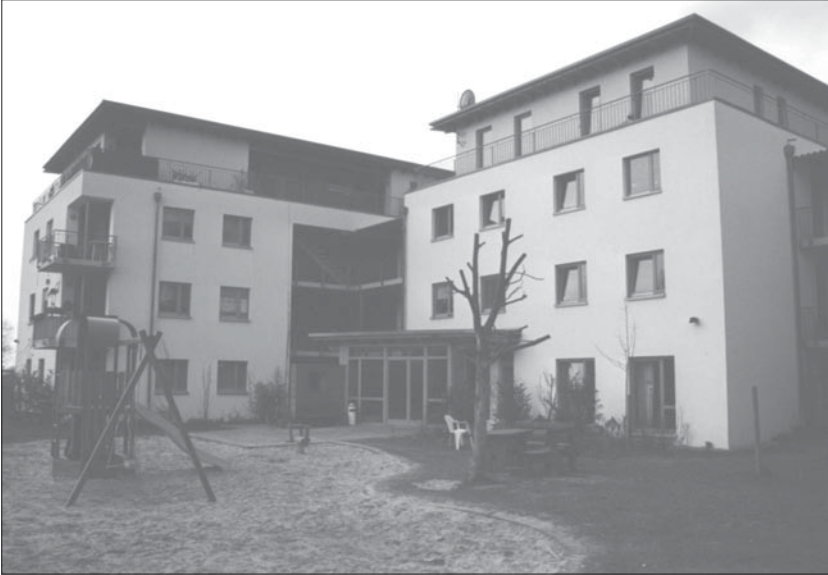
Abb. 11: Rückseite der Wohnanlage
