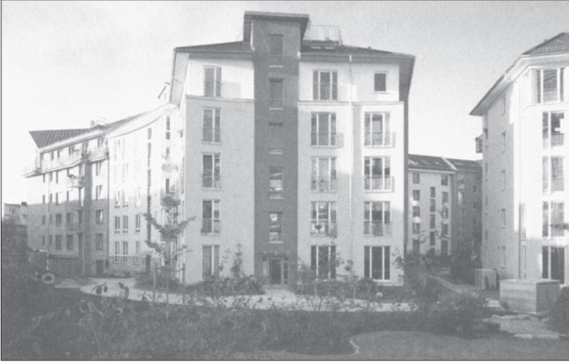
Abb. 14: Wohnungsbauvorhaben Zeisewiese mit insgesamt 17 Wohnprojekten
