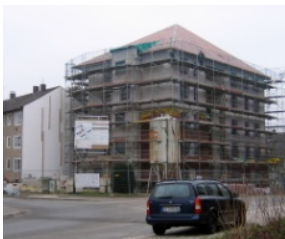
Abbildung 9-11: Neubau des Nachbarschafts- zentrums Schweitzer-Straße
