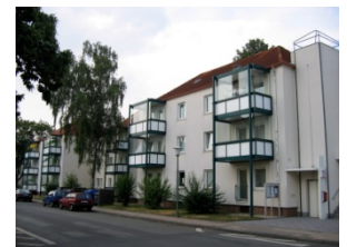
Abbildung 9-12: Sanierte Bestandsbauten der ‚Freien Scholle‘
