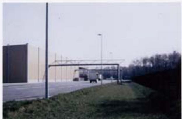
Abb. 8-11 Dachentwässerung über Rohrbrücken in oberflächennah angelegte Bewirtschaftungsfläche
