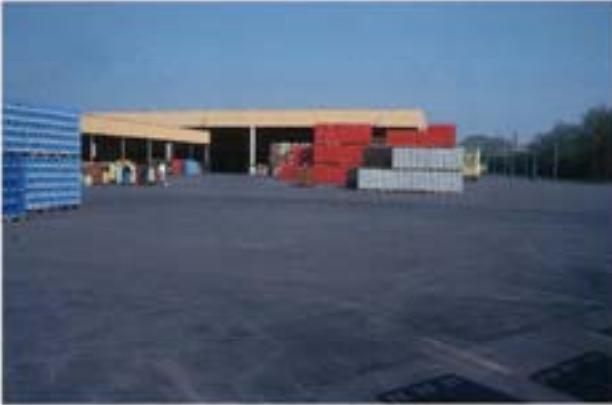
Abb. 7-34 Befestigte Lagerflächen und Hallenbauten
