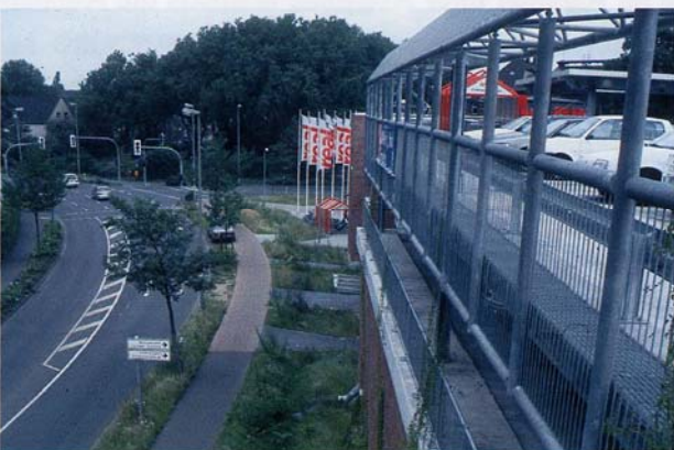
Abb. 7-20 Mulden-Rigolen-Elemente drei Jahre nach Inbetriebnahme
