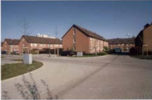
Abb. 7-59 Offene Rinnenführung im Kreuzungsbereich der Straße
