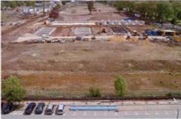
Abb. 7-73 Übersicht Baufeld zu Beginn der Bebauung
