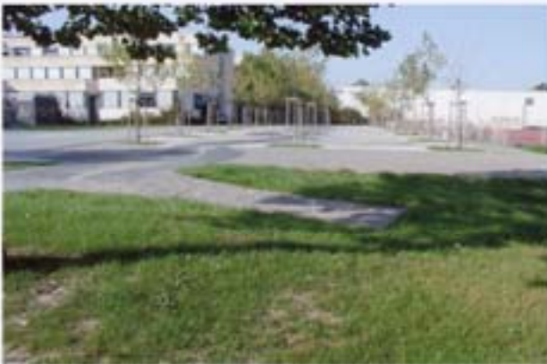
Abb. 7-122 Im Rahmen der Regenwasserbewirtschaftungsmaßnahmen neugestalteter Schulhof (offene Rinne als zentrales Gestaltungselement)
