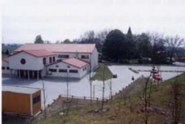
Abb. 7-93 Naturnahe Bewirtschaftung der Abflüsse bei neuem Sortenzentrum über Mulden und Mulden-Rigolen-System
