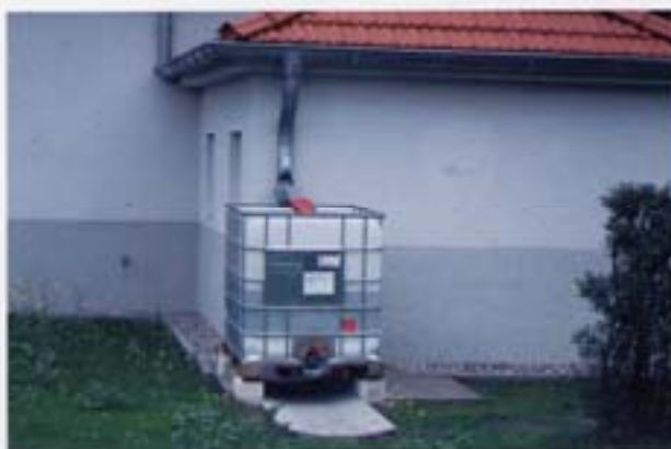
Abb. 7-101 Muldenversickerung mit zwischengeschalteter Regenwassernutzung zur Gartenbewässerung
