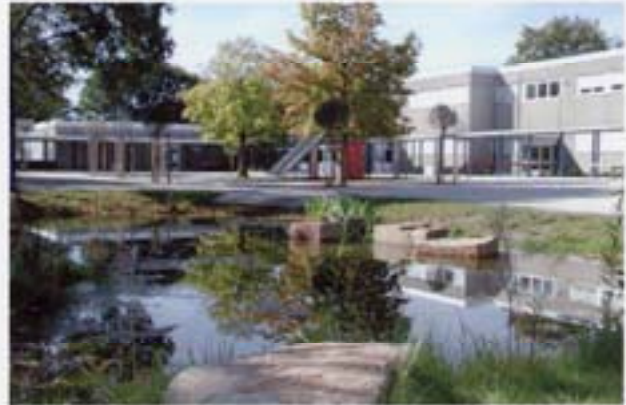
Abb. 7-121 Im Rahmen der Regenwasserbewirtschaftungsmaßnahmen neugestalteter Schulhof
