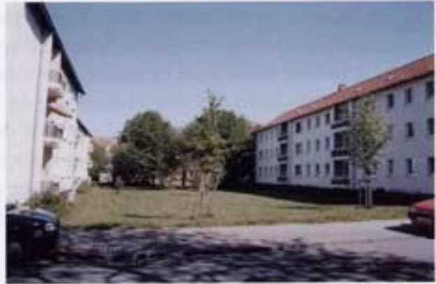
Abb. 7-82 Breitflächige Versickerungsmulden nach Fertigstellung
