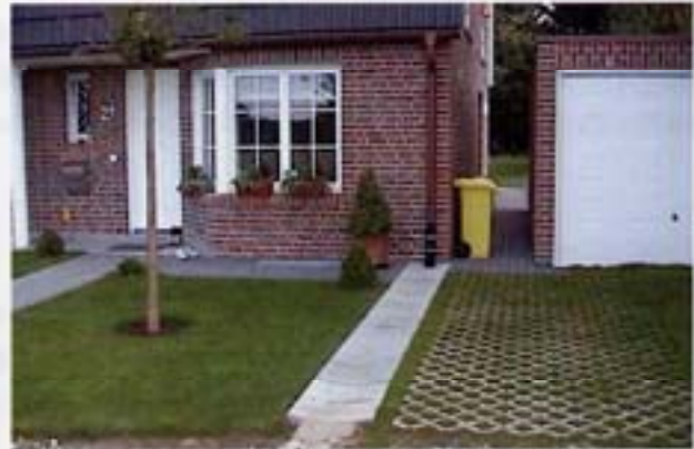
Abb. 7-68 Offene Ableitung von privaten Grundstücksflächen auf öffentliche Straße (Baustraße) und wasserdurchlässige Befestigung von Garagenzufahrten
