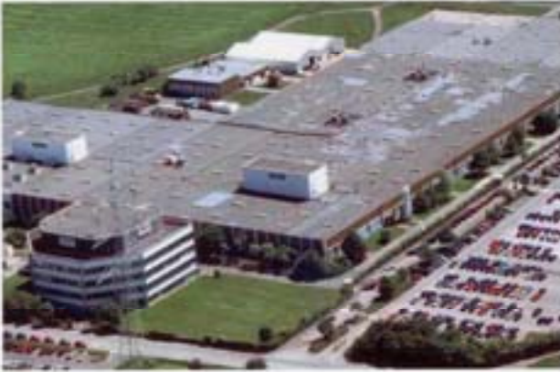
Abb. 7-106 Abgekoppelte Dachfläche der Produktionshalle Fa. Vogt-elektronic
