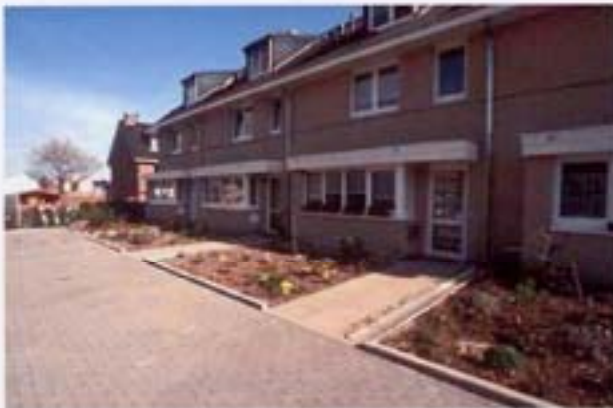
Abb. 7-74 Offene Ableitung der Dachabflüsse auf öffentliche Verkehrsflächen
