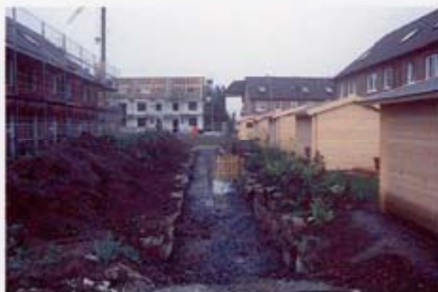
Abb. 8-15 Die Vorbehalte der Straßenbauverwaltung die nach vorne geneigten Dachflächen über die öffentliche Straße zu entwässern zieht tiefeingeschnittene Dungwege nach sich
