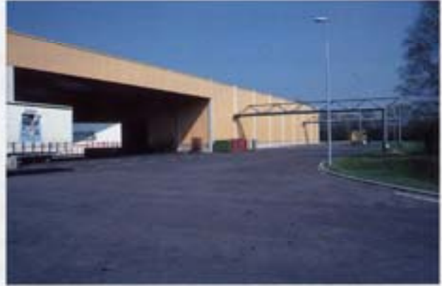
Abb. 7-35 Offene Ableitung der Dachabflüsse mithilfe von Rohrbrücken
