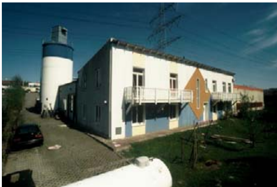
Abb. 7-5: Verwaltungstrakt mit Einliegerwohnung und als Freisitz genutzte Versickerungsfläche
