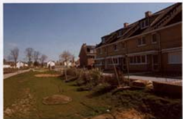
Abb. 7-77 Sicherung der Regenwasserbewirt- schaftungsflächen in der Bauphase mit Bauzaun
