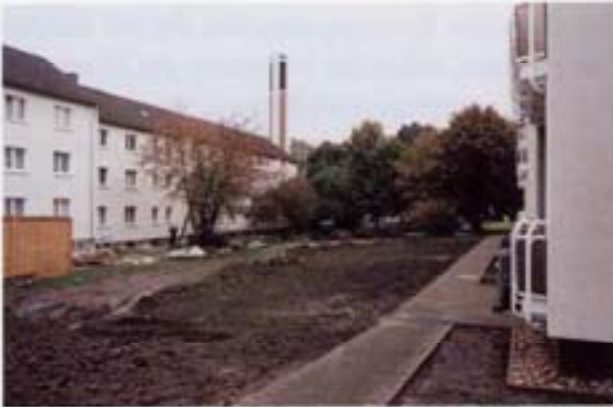
Abb. 7-81 Versickerungsmulden im Bau
