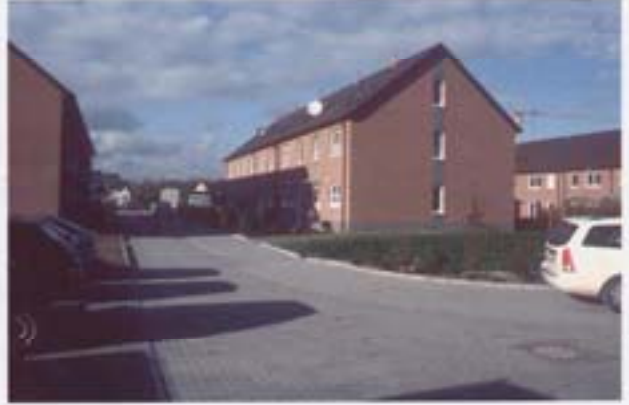
Abb. 7-60 Straßenquerschnitt mit Mittelrinne zur offenen Regenwasserableitung
