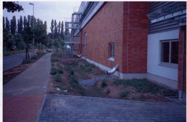
Abb. 7-19 Mulden-Rigolen-Elemente fertiggestellt
