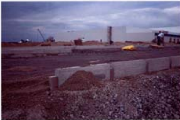
Abb. 7-52 Auf Lücke gesetzte Hochborde zur offenen Ableitung der Abflüsse im Bau
