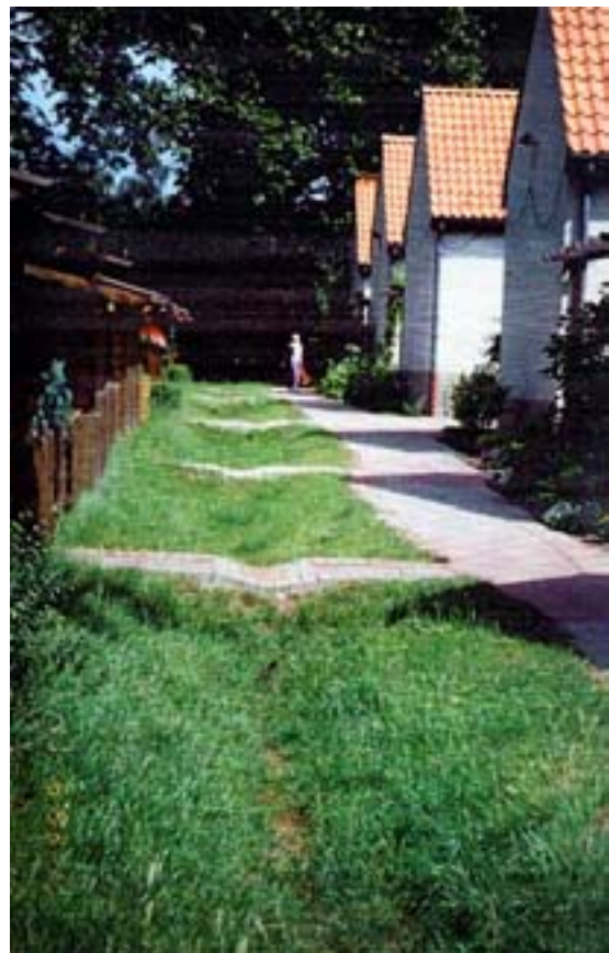
Abb. 3-10: Bild links: fälschlicherweise grabenartig erstellte Mulden mit steilen Böschungen machen Einfriedung erforderlich Bild rechts: Rückbau der zu tief angelegten Versickerungsmulden in den Planungszustand macht Einfriedung entbehrlich
