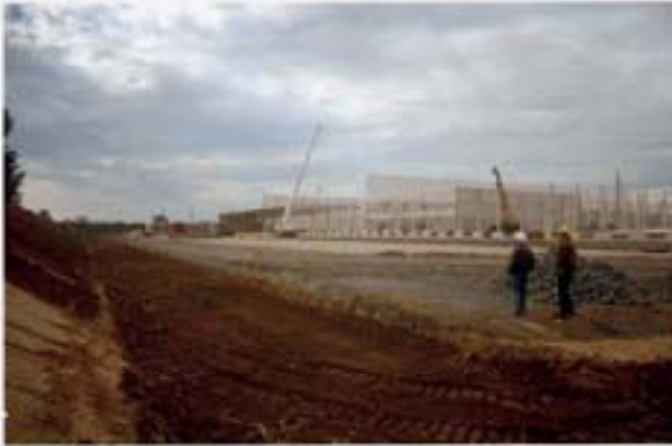
Abb. 7-50 Ikea Logistikzentrum im Bau- im Vordergrund die umlaufende Transportmulde
