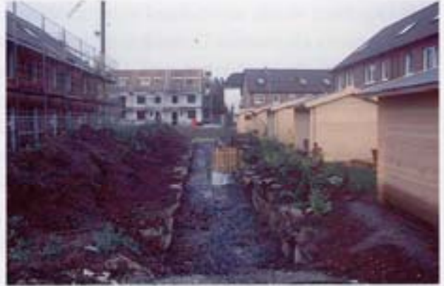
Abb. 7-62 Rückwärtig angelegte Dungwege zur Ableitung des Regenwassers von den privaten Grundstücken
