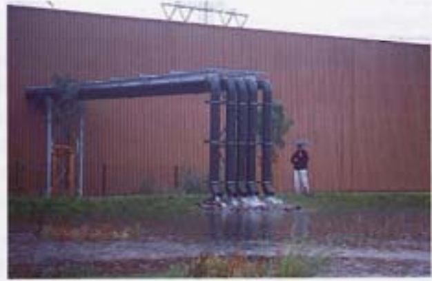
Abb. 7-107 Offene Ableitung der Dachabflüsse über Rohrbrücken
