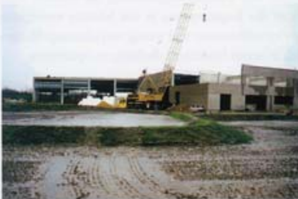
Abb. 7-27 Versickerungsmulden noch ohne schützende Vegetationsdecke im November 1994
