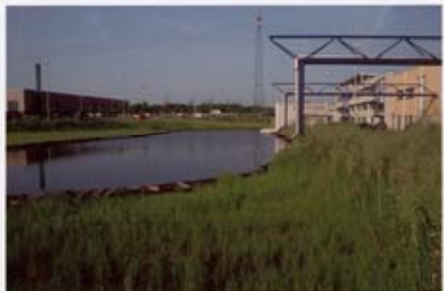
Abb. 7-47 Regengespeister Feuerlöschteich mit umlaufender Versickerungsmulde
