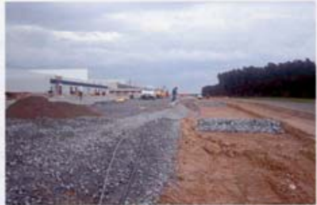
Abb. 7-51 Transportmulde im Bau (rechts)
