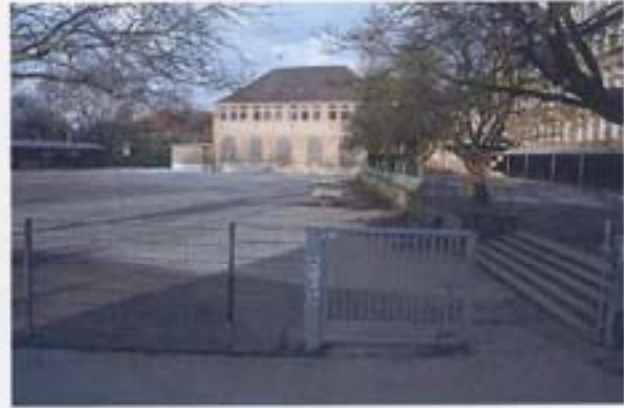
Abb. 7-84 Schulhof der Kreuzgrundschule vor Abkopplung des Regenwassers
