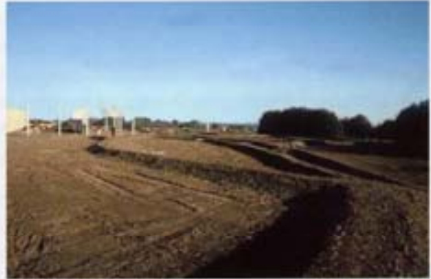
Abb. 7-26 Versickerungsmulden im Bau
