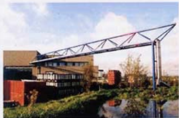
Abb. 8-6 Rohrbrücke und höher gelegene Bewirtschaftungsflächen
