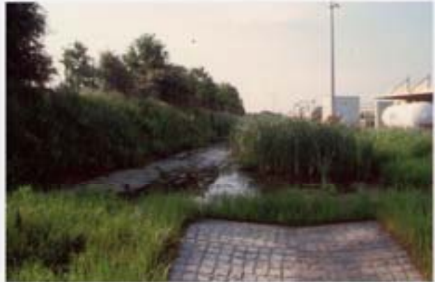
Abb. 7-45 Partielle Regeneration der verschlammten Versickerungsmulden zwei Jahre nach Inbetriebnahme
