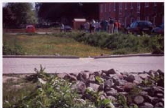
Abb. 8-16 Die Böschungshöhen der semizentralen Bewirtschaftungsflächen lassen sich bei konsequenter offener Ableitung reduzieren
