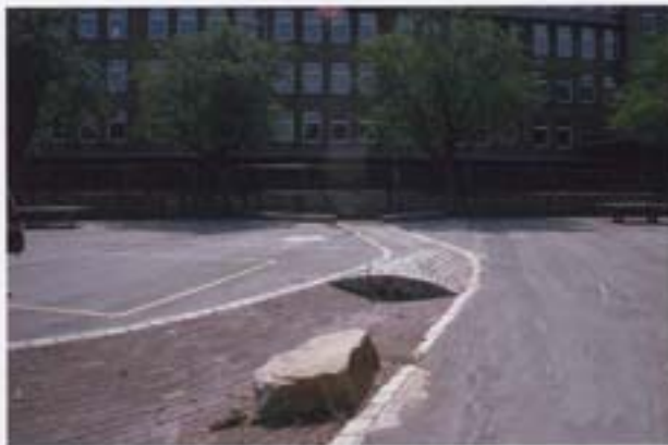
Abb. 7-85 Zentrale Rinne zur offenen Ableitung des Niederschlagswassers von Dach und Schulhofflächen
