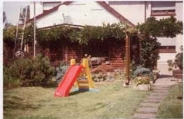
Abb. 7-90 Offene Ableitung des Regenwassers bei Gegengefälle über Pergolen-Übertragung der Rohrbrückentechnik aus dem Gewerbe auf den Wohnbereich
