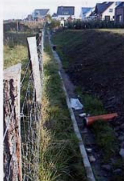
Abb. 7-70 Querschnitt des Ableitungskorridors durch Anfüllung privater Grundstückseigentümer fast vollständig beseitigt
