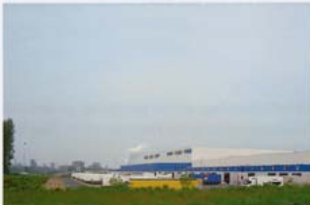
Abb. 7-54 Transportmulde (links), befestigte Rangierfläche (Mitte) und Hallengebäude (rechts)
