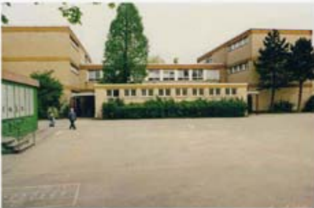
Abb. 7-120 Typische Schulhofsituation in Scharnhorst-Ost vor dem Regenwasserprojekt
