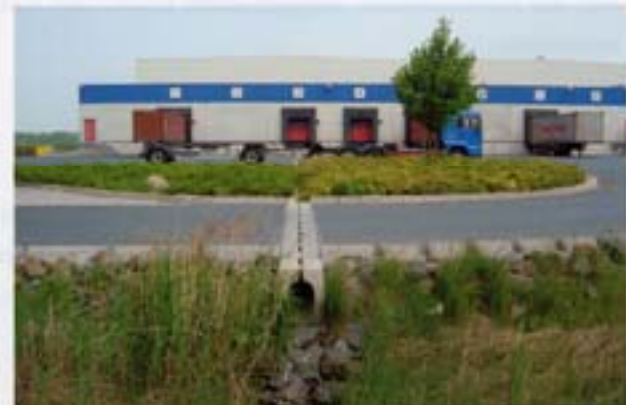
Abb. 7-55 Schlitzrinne zur Entwässerung der Dachflächen
