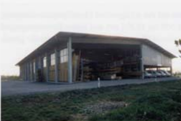
Abb. 7-12 Versickerungsmulden im rückwärtigen Bereich (1)
