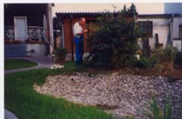
Abb. 7-111 Versickerungsanlage in Privatgarten
