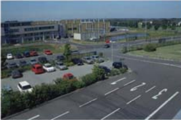
Abb. 7-42 Befestigte Verkehrsflächen, Hallengebäude mit Rohrbrücken, Kombination von Feuerlöschteich und umlaufender Versickerungsmulde
