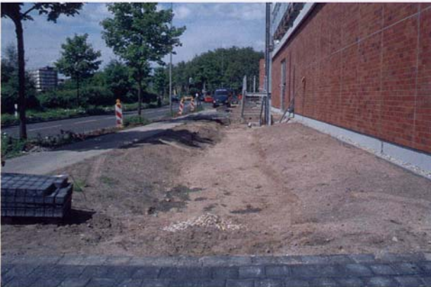
Abb. 7-18 Mulden-Rigolen-Elemente im Bau
