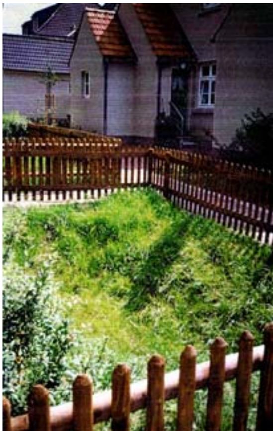
Abb. 3-10: Bild links: fälschlicherweise grabenartig erstellte Mulden mit steilen Böschungen machen Einfriedung erforderlich Bild rechts: Rückbau der zu tief angelegten Versickerungsmulden in den Planungszustand macht Einfriedung entbehrlich
