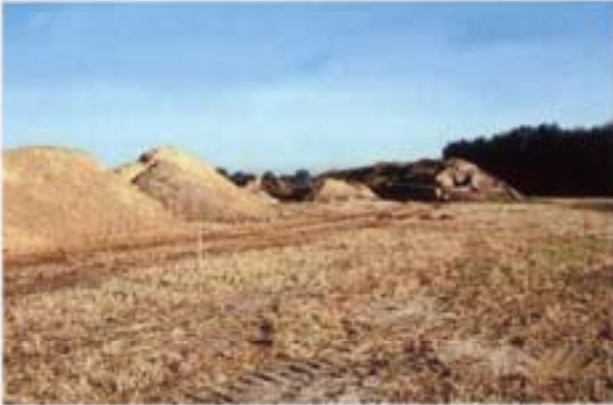
Abb. 7-25 Aushub des Geländes als Material zur Erstellung der Muldenkaskade
