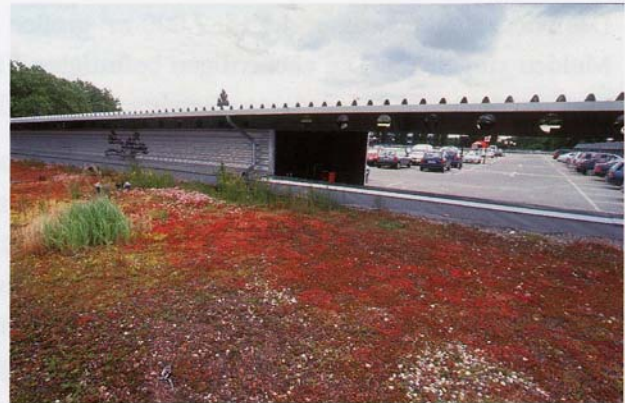
Abb. 7-17 Dachfläche extensiv begrünt und als Parkpalette genutzt
