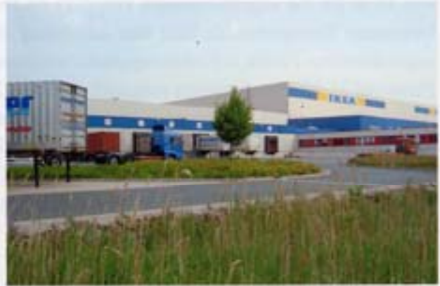
Abb. 7-53 Auf Lücke gesetzte Hochborde zur offenen Ableitung der Abflüsse nach Fertigstellung
