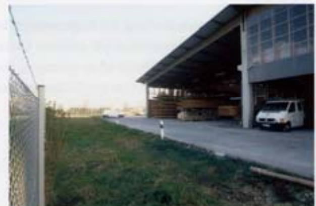
Abb. 7-13 Versickerungsmulden im rückwärtigen Bereich (2)
