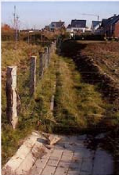
Abb. 7-69 Querschnitt des Ableitungskorridors durch Anfüllung privater Grundstückseigentümer reduziert
