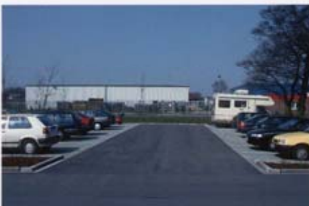
Abb. 8-10 Offene Ableitung der Abflüsse über Quergefälle
