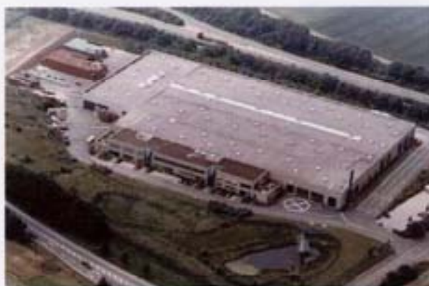
Abb. 8-5 Rohrbrücken überspannen tiefergelegene Betriebsflächen (links im Bild)
