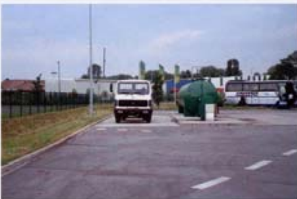
Abb. 7-38 Betriebstankstelle mit separater Oberflächenentwässerung
