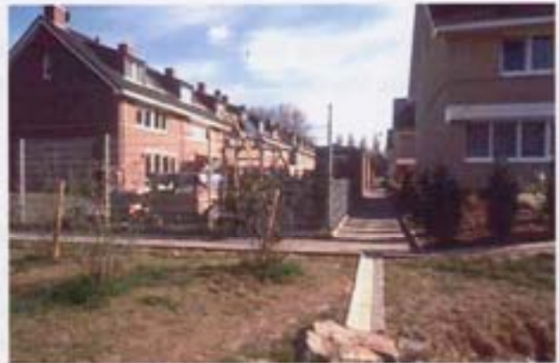
Abb. 7-75 Offene Ableitung der Abflüsse aus dem Baugebiet über Wohnwege
