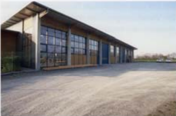
Abb. 7-10 Teildurchlässig befestigte Betriebsfläche (wassergebundene Decke)
