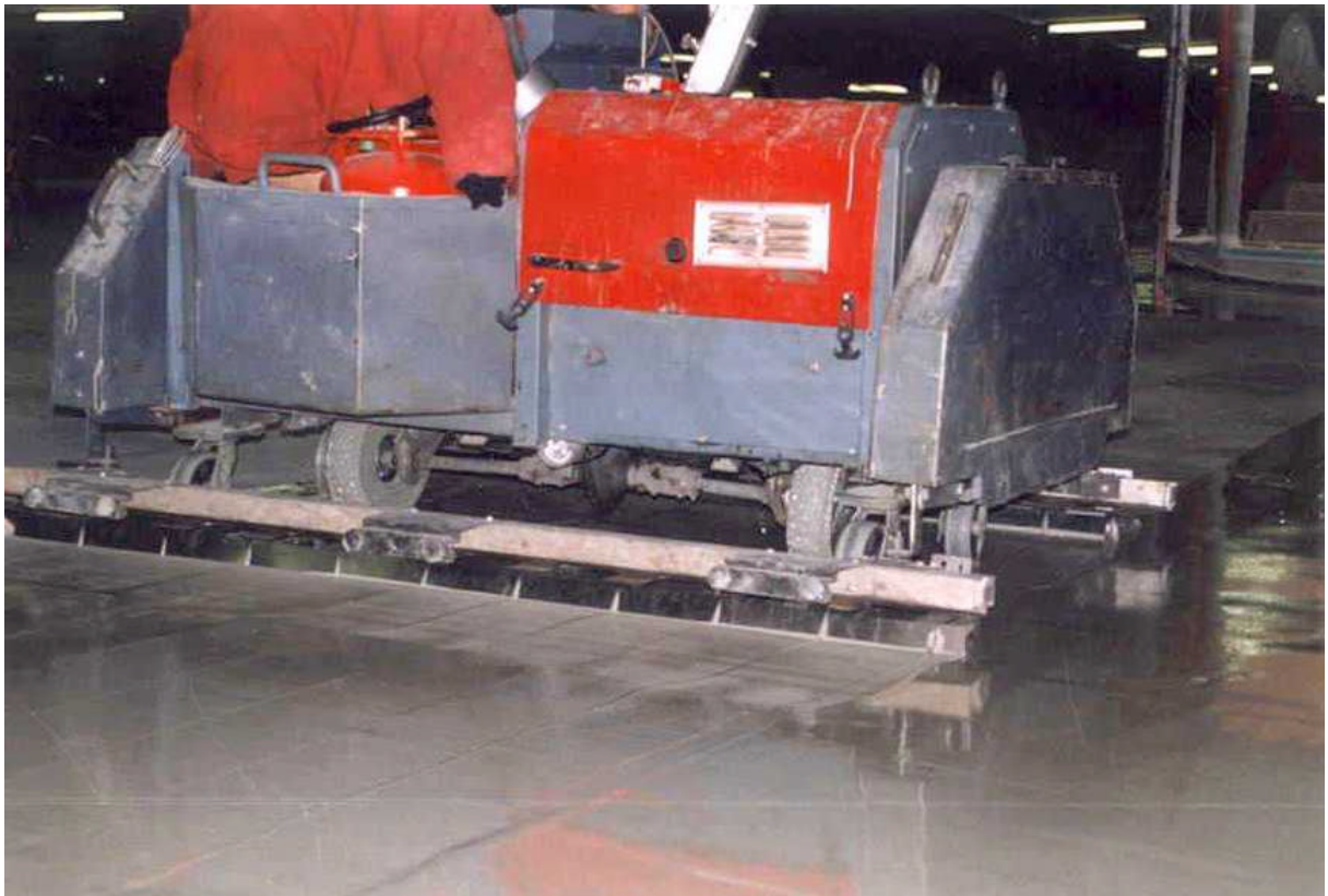
Bild 59: Einbaufertiger mit 2 m breiter Zahnleiste aus 10 Zahnsegmenten
