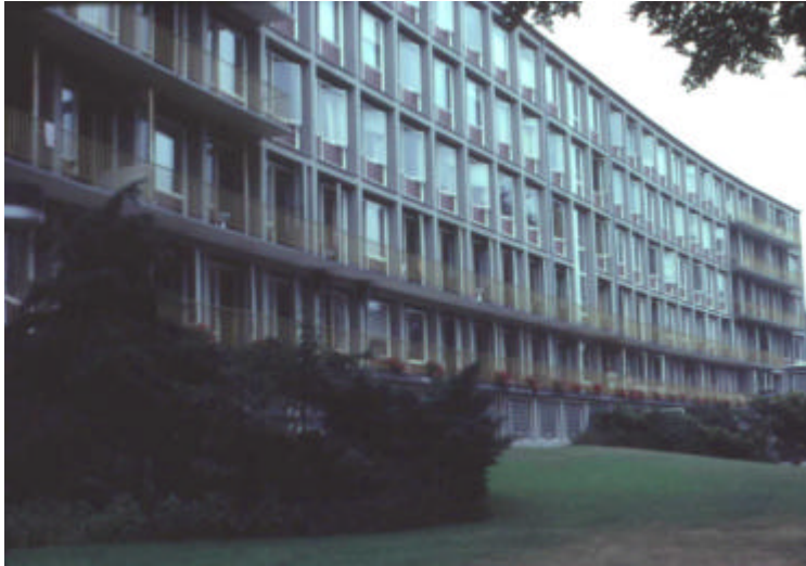
Bild 12: Auskragende Balkonplatte, 1. OG
