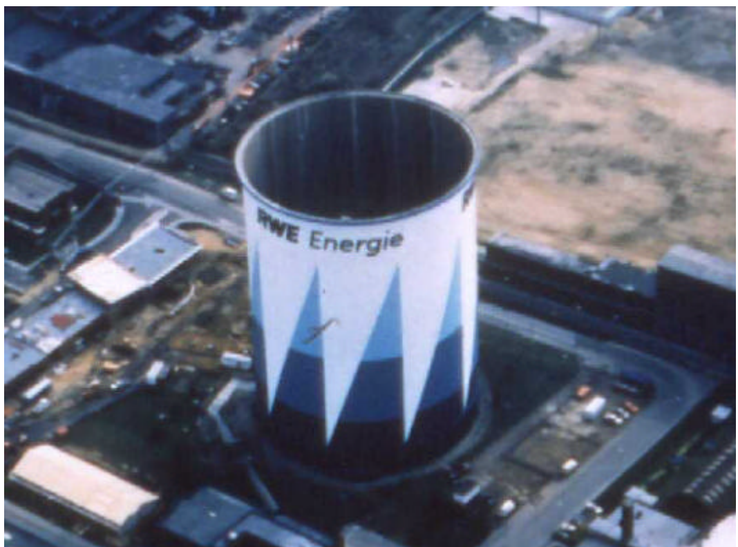
Bild 8: Kühlturm nach Ausführung der Beschichtungsmaßnahme, außen
