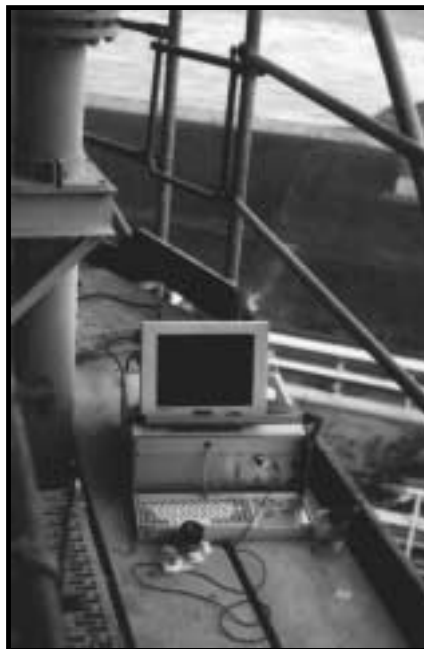
BILD 6.1: Prüfgerät im Einsatz
