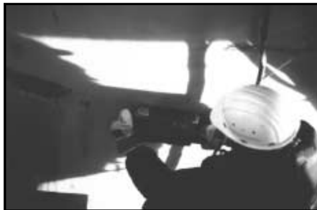
BILD 6.6: Abschleifen der Oberfläche
