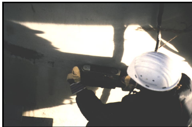
BILD 6.6: Abschleifen der Oberfläche
