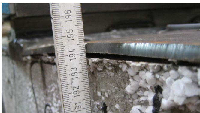
Bild 9.18: Beulverformung des gedrückten Obergurtes (unteres Deckblech) bei einer Prüflast von 600 kN
