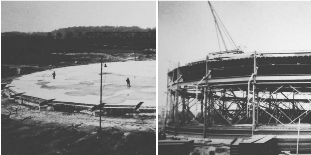
Abb. 237 „Gasometer Oberhausen“ im Bau, Konstruktion der Bodenplatte, Foto: o. N., Quelle: Archiv AfsB 2009, 19.05.1928; Abb. 238 „Gasometer Oberhausen“ im Bau, Konstruktion der Gasdruckscheibe, Foto: o. N., Quelle: Archiv AfsB 2009, 17.09.1928
