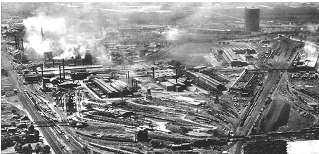
Abb. 232 Gelände der „Gutehoffnungshütte“ in Oberhausen; „Gasometer Oberhausen“ hinten rechts im Bild, Foto: o. N., Quelle: Archiv AfsB 2009, o. J.
