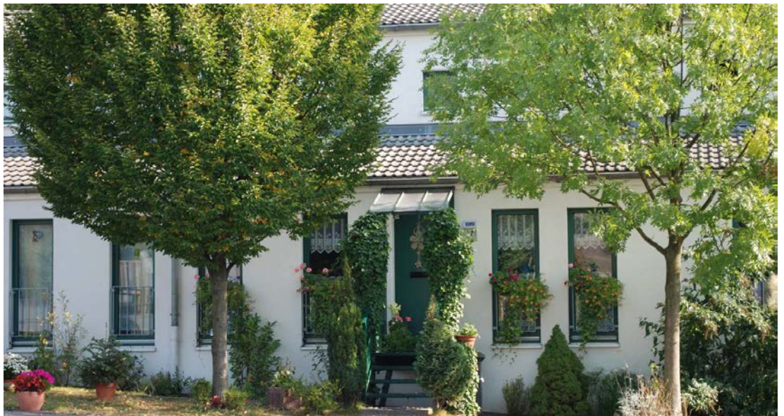
Abb. 330 Neuer Siedlungsteil, Zum Runenberg, Foto: Burggräf, 2010
