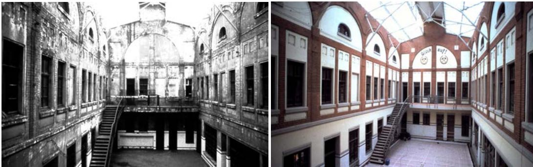
Abb. 98 „Zeche Arenberg“ vor der Sanierung durch die IBA, Bottrop, Quelle: Archiv AfsB 2009, o. J.; Abb. 99 „Gründerzentrum und Gewerbestandort Arenberg“ nach der Sanierung durch die IBA, Bottrop, Quelle: Archiv AfsB 2009, o. J.
