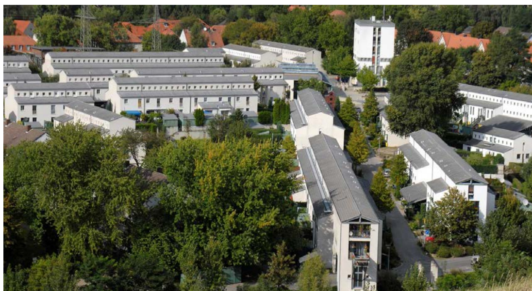
Abb. 263 Sechsgeschossiges Punkthochhaus am Schüngelbergplatz, Blick von der Halde, Foto: Uwe Grützner, TU Dortmund, Fakultät Raumplanung, 2007
