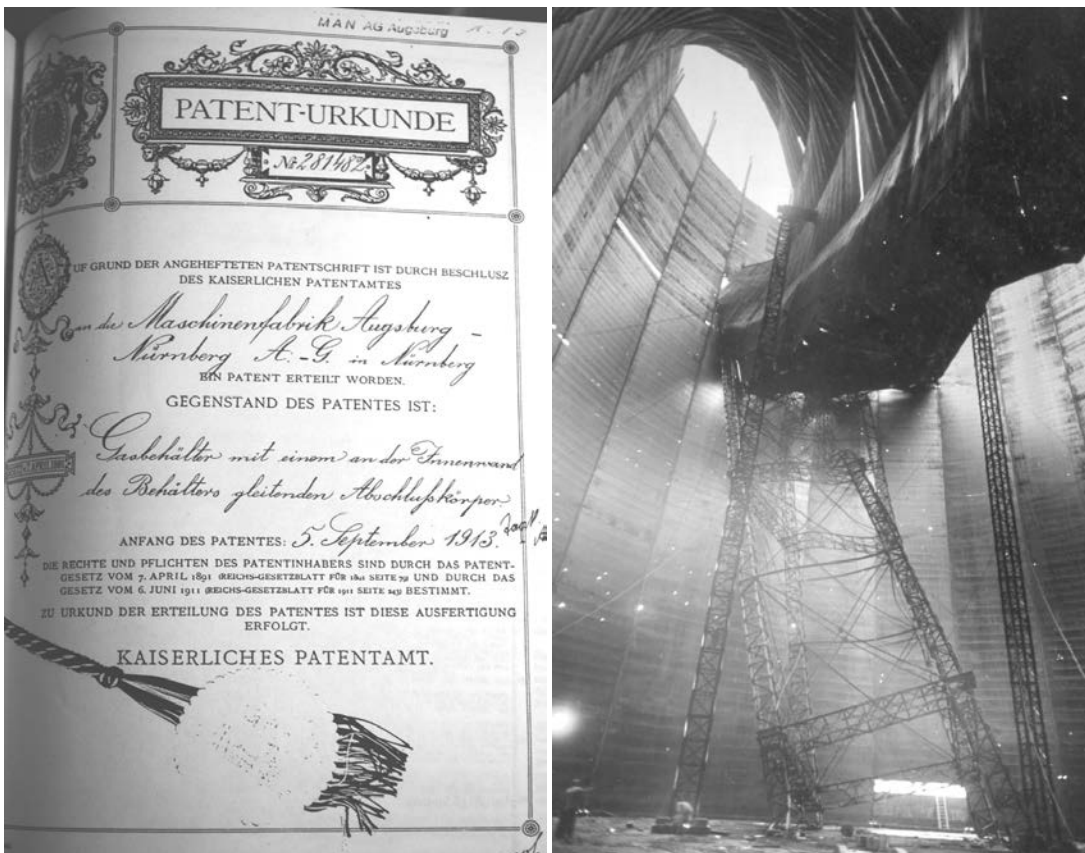
Abb. 239 Patenturkunde des Kaiserlichen Patentamtes, Quelle: Archiv AfsB 2009, 05.11.1913; Abb. 240 Einsturz des Gasometers nach Brand, Quelle: Archiv AfsB 2009, 1946
