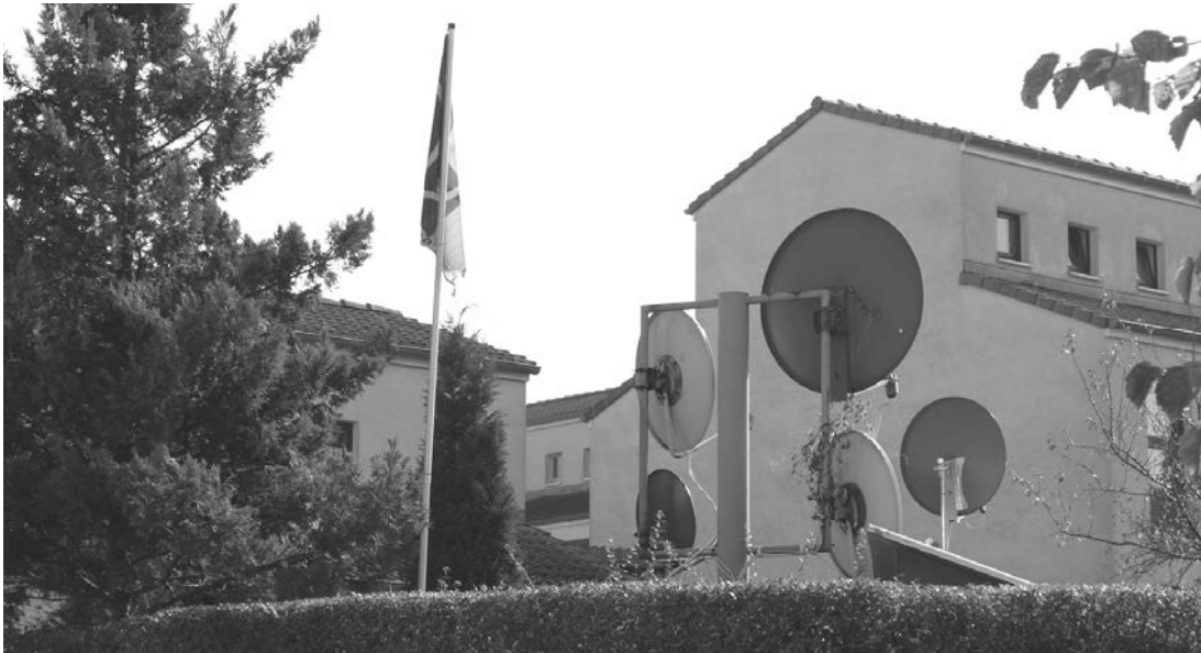
Abb. 351 Zentrale Empfangsschüsseln für die gesamte „Siedlung Schüngelberg“, Foto: Burggräf, 2010
