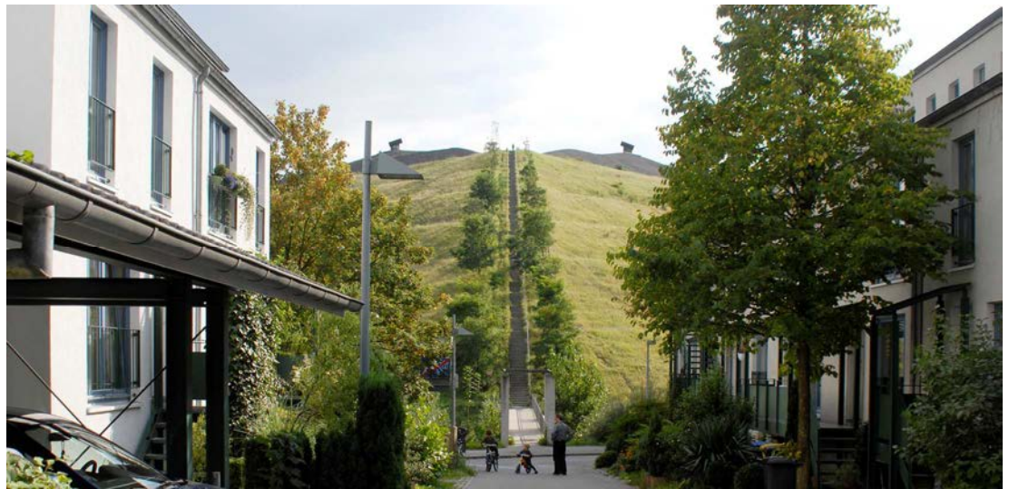
Abb. 374 Brücke über den Lanferbach und Treppenanlage auf die „Halde Rungenberg“, Foto: Uwe Grützner, TU Dortmund, Fakultät Raumplanung, 2007
