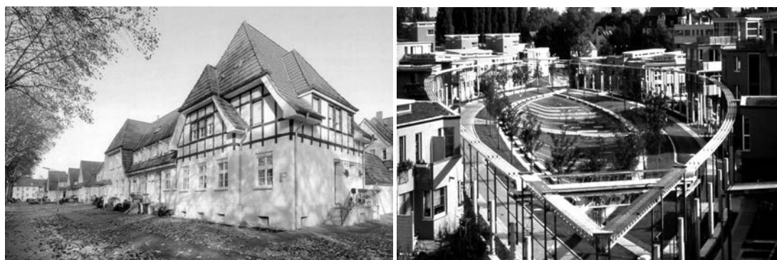
Abb. 108 „Siedlung Welheim“, Bottrop, Quelle: Archiv AfsB 2009, o. J.; Abb. 109 „Siedlung Küppersbusch“, Gelsenkirchen, Quelle: Archiv ebd., o. J.
