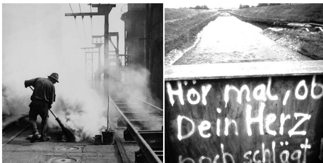
Abb. 67 Arbeiter auf einer Koksofendecke, Quelle: Archiv SIUG 2010, o. J.; Abb. 68 Emscherbrücke, Quelle: Archiv AfsB 2009, o. J.
