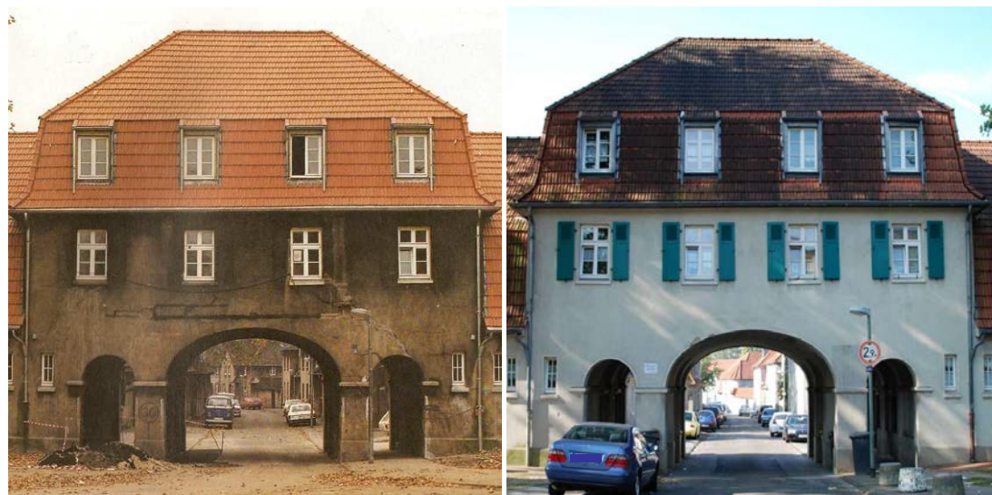
Abb. 103 Alte „Siedlung Schüngelberg“, Historisches Torhaus vor der Sanierung, Quelle: Minister für Stadtentwicklung, Wohnen und Verkehr des Landes Nordrhein-Westfalen: „Internationale Bauausstellung Emscher-Park. Werkstatt für die Zukunft alter Industriegebiete. Memorandum zu Inhalt und Organisation“, Düsseldorf, 1989, Seite 24 ff.; Abb. 104 Alte „Siedlung Schüngelberg“, Blick auf das Torhaus, Gertrudstraße, Foto: Burggräf, 2010
