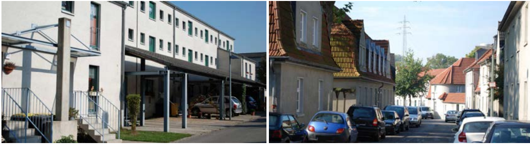
Abb. 378 Neue „Siedlung Schüngelberg“, Foto: Burggräf, 2010; Abb. 379 Alte „Siedlung Schüngelberg“, Kleinteiligkeit und Individualität, Gertrudstraße, Foto: Burggräf, 2010
