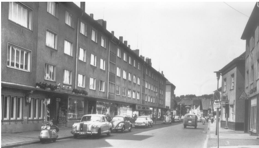
Abb. 46: Die Blessenstätte wurde ab 1953 mit zunächst 30 Wohnungen wiederaufgebaut, 1954 folgten weitere 42 Wohnungen, Fertigstellung 1955. Blick auf südliche Front, 1959. Quelle: Stadtarchiv Gütersloh, Fotosammlung BB 05239 (Postkarte Cramers Kunstanstalt, Dortmund).
