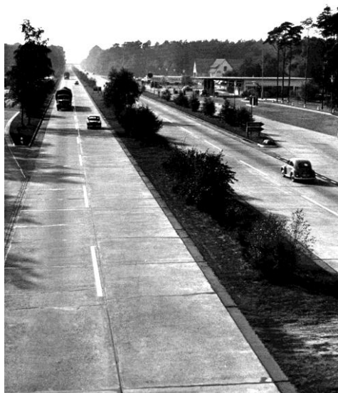
Abb. 17: In den frühen 1950er Jahren hatte die BAB 2 noch das Aussehen ihrer Entstehungszeit. Aufnahme ca. 1956, Blick Fahrtrichtung West mit Raststätte Gütersloh Nord. Quelle: Kraak, Hagen: Gütersloh, Gütersloh 1956; ohne Seitenzahl.
