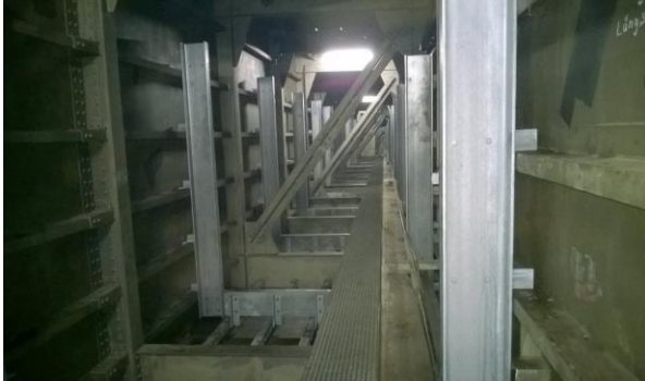
Bild 2.21: Verstärkungsrahmen Severinsbrücke Köln
