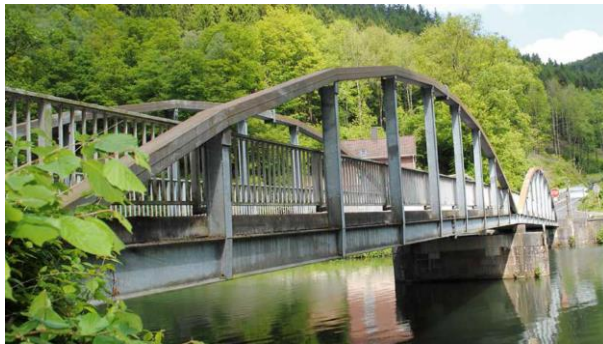
Bild 2.20: Feuerverzinkte Straßenbrücke über die Lenne (D) – zul. Verkehrsbelastung 12 t [43]
