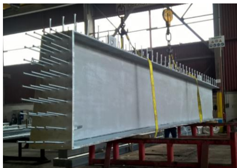
Bild 8.9: Heben mit textilen Schlingen
