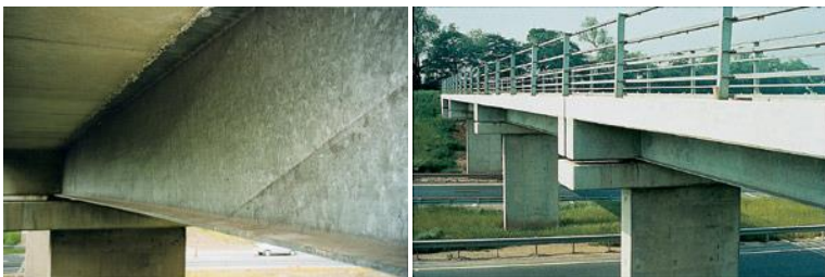
Bild 2.18: Feuerverzinkte Autobahnbrücke bei Stainsby Hall, UK [45]
