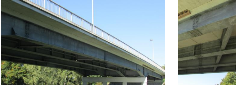
Bild 8.6: Geschraubter Laschenstoß der Hauptträger einer Verbundbrücke in Belgien (Fotos: Voigt & Schweitzer GmbH & Co. KG)
