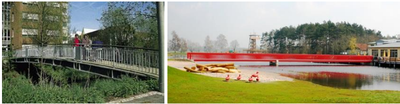
Bild 2.16: Feuerverzinkte Fußwegbrücken in Göttingen, 1988 (links) [44] und Rietberg (mit zusätzlicher Beschichtung = Duplexsystem), 2007 (rechts) [64]
