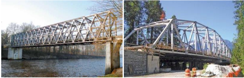
Bild 2.17: Ehzer-Brücke, Almen, NL (links) [46] und Sauk River, Washington, USA (rechts) [1]
