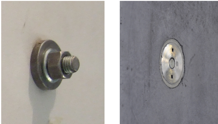
a) aufgesetzte Montage
