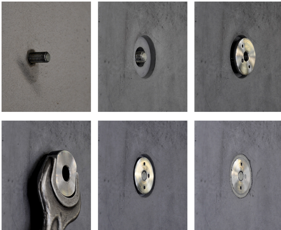
Bild 3.6 Ausführung Montage und Ankerkopf bei den Prototypen
