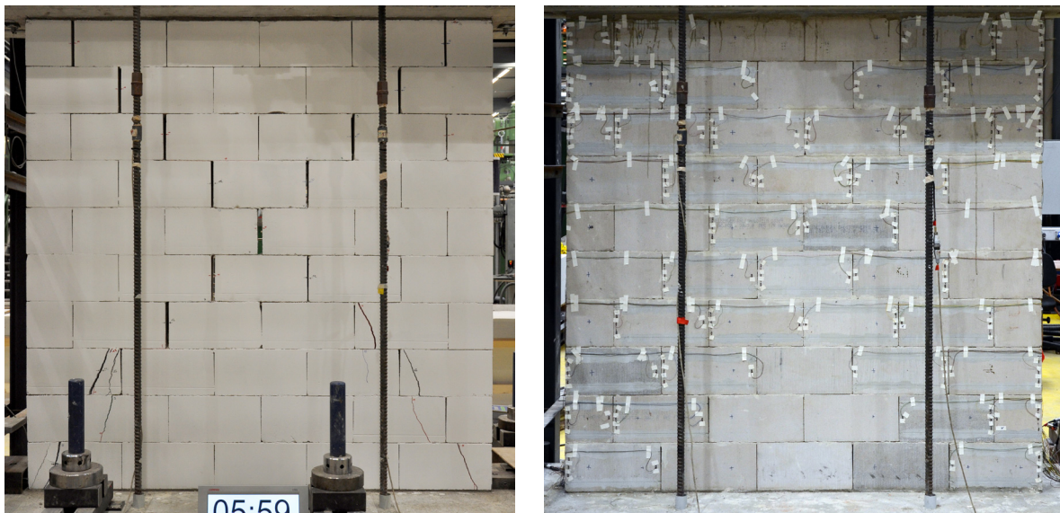
Bild 4.17 Rissbild unverstärkte Mauerwerkswand (WV01) / Instrumentation Detektion Steinrisse (WV03)
