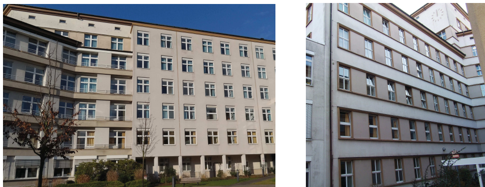
Abbildung 3.3: links: sanierte Südfassade, rechts: unsanierte Nordfassade des Haupthauses
