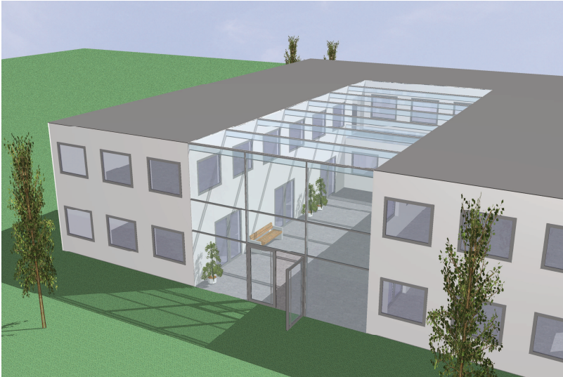
Bild 8.9 Stahl-Glas-Träger als Innenhofüberdachung
