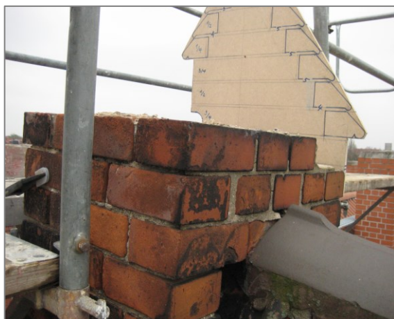
Abbildung 145 Ermittlung des Überdeckungswinkels der Schrägsteine Bauschablone und probeweiser Aufbau der Giebeltürmchen
