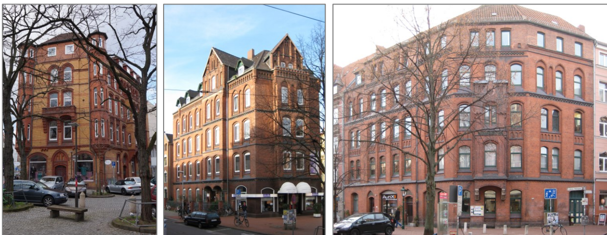
Abbildung 120 Beschädigte Blockspitze oder Stumpfwinkelbebauung 09 An der Apostelkirche 4, 09 Lister Meile 29A, 10 Drotestraße 1, 34 Niemeyerstraße 6 und 34 Lindener Marktplatz 7
