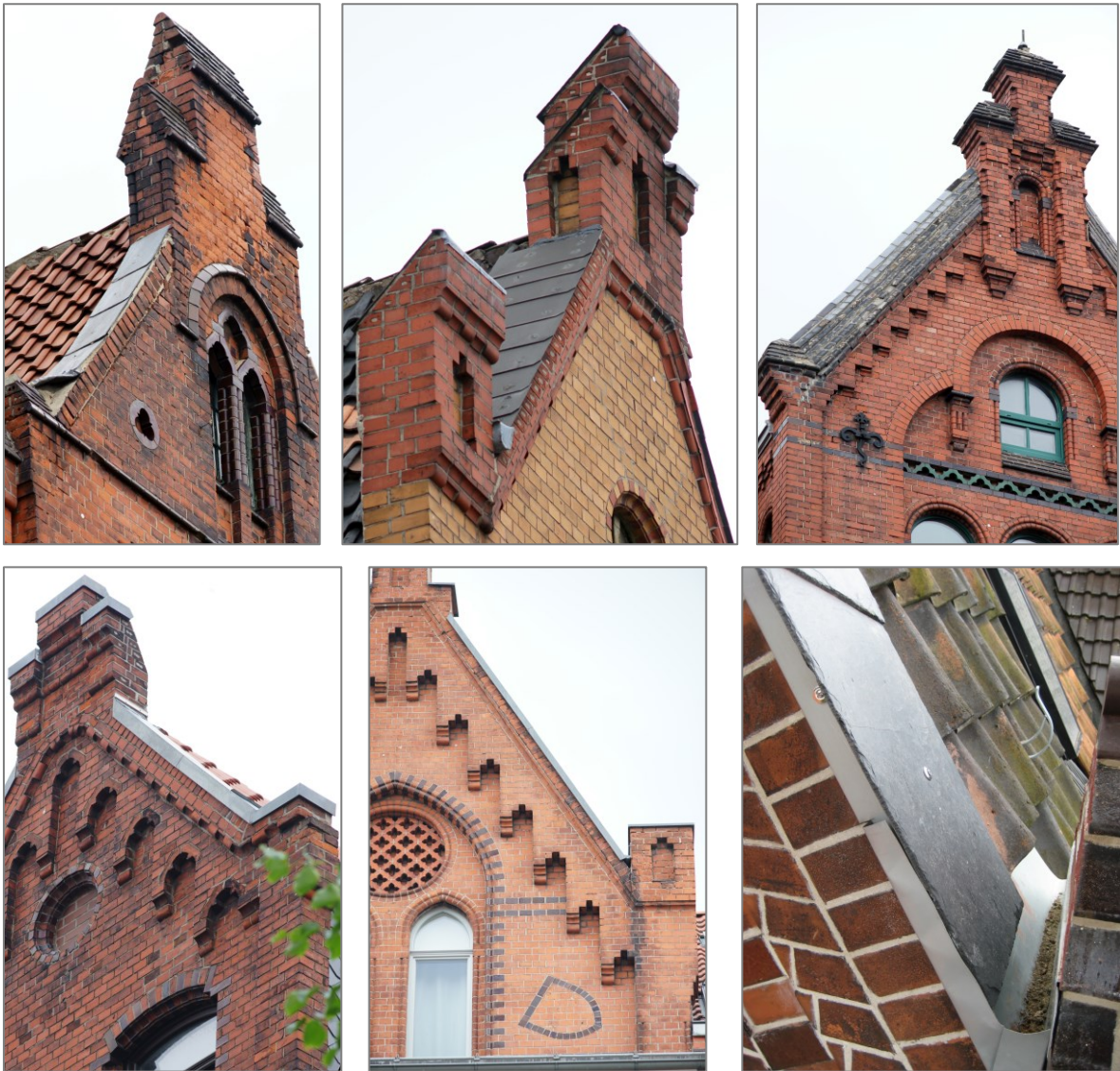
Abbildung 18 Ortganggestaltung mit Rollschicht oder Blende Einfache Ortganggestaltung mit Rollschicht, die Neigung des Giebels gegen den Dachstuhl ist deutlich zu erkennen (09 Gretchenstraße 44), Schmales Ortgangsims und Abdeckung des Ortgangs mit Schiefer (03 Hahnenstraße 1), Treppensims (34 Schwalenberger Straße 5), Blendarkadengesims in der 08 Gellertstraße 46 und in der 09 Rambergstraße 13, Detail eines Kehleblechs am Fußpunkt der Ortgangabdeckung (01 Dieterichsstraße 26)
