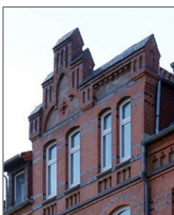
Abbildung 41 Ein seltsamer Giebel an Eckhaus 33 Velvetstraße 2 Der linke Teil des Giebels ist mit dem Eck- und dem andern Seitengiebel identisch, musste aber wohl verbreitert werden, weil der Risalit bereits doppelt breit aufgeführt worden war
