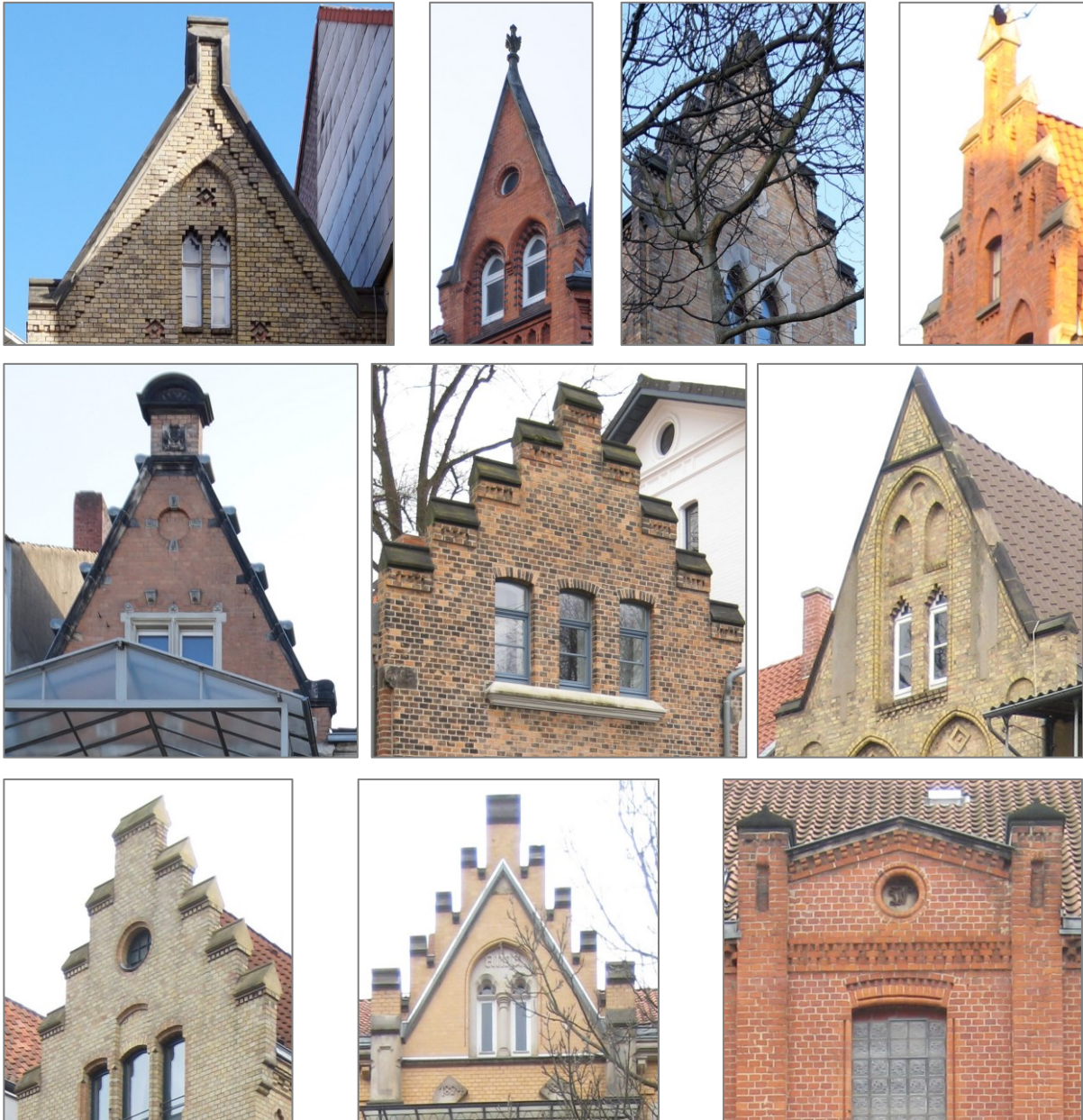
Abbildung 24 Sandsteinabgedeckte Giebel 01 Blumenstraße 7, 01 Hanns-Lilje-Platz 1, 01 Schiffgraben 43, 03 Im Moore 24, 04 Walter-Gieseking-Straße 3, 08 Ellernstraße 1, 08 Friedenstraße 8, 08 Hindenburgstraße 20, 09 Hohenzollernstraße 21, 34 Fössestraße 59
