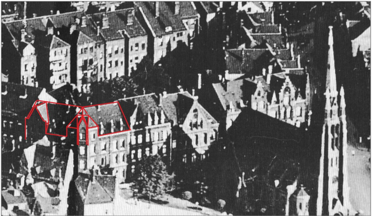
Abbildung 214 Ausschnitt aus einem Luftbild . Die Dach- und Giebellandschaft hinter der Kirche ist vollständig abhandengekommen, mittig steht das nur 2 ½ - geschossige ehemalige Gemeindehaus. Die Dachkanten des Eckhauses An der Apostelkirche 4 wurden in rotem Strich nachgezeichnet, Röhrbein, et al., 1998 S. 22
