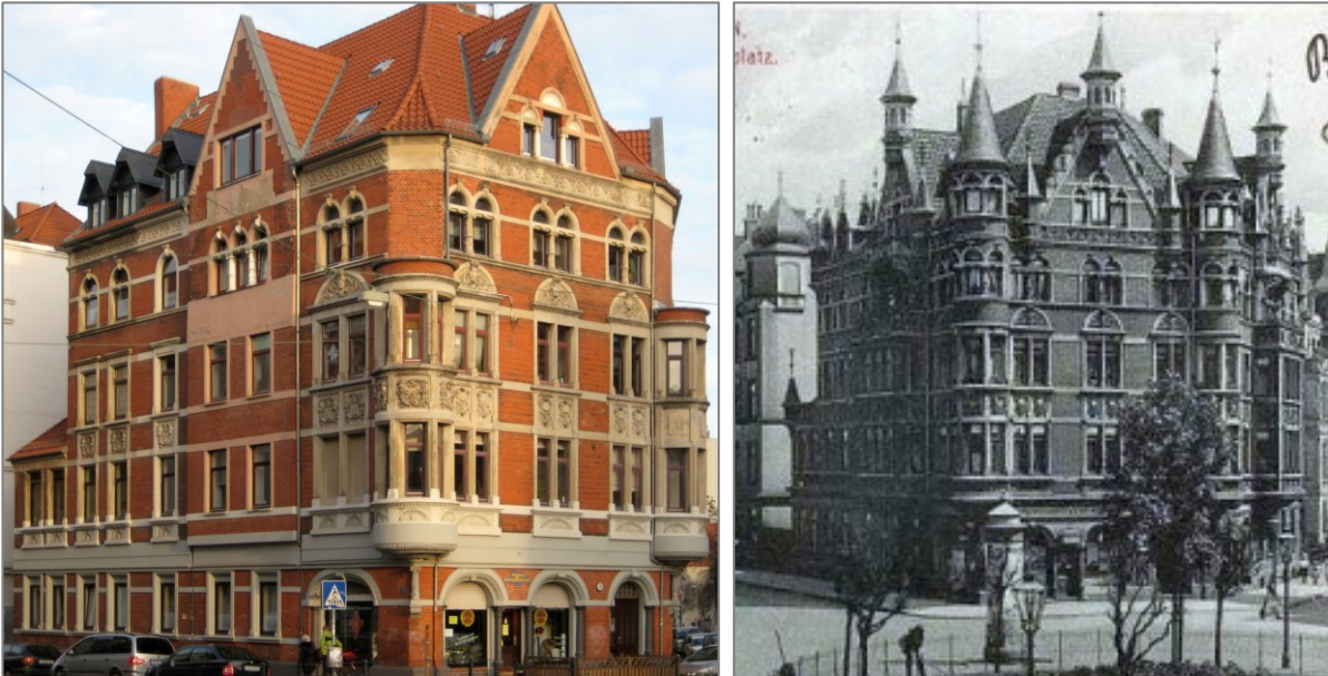
Abbildung 54 Doppelturmfassade am Lichtenbergplatz 3
