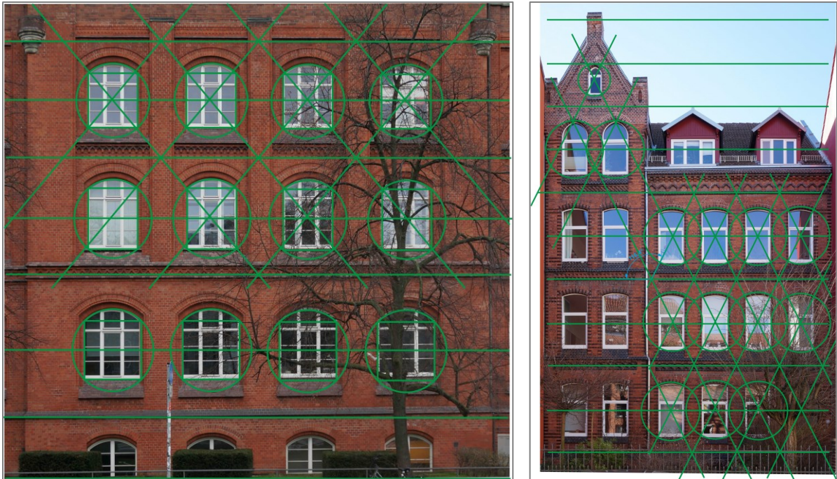
Abbildung 91 Die "Jägerzaun"-Fassade" "König & Ebhardt" 03 Schloßwender Straße 1; 01 Dieterichsstraße 26
