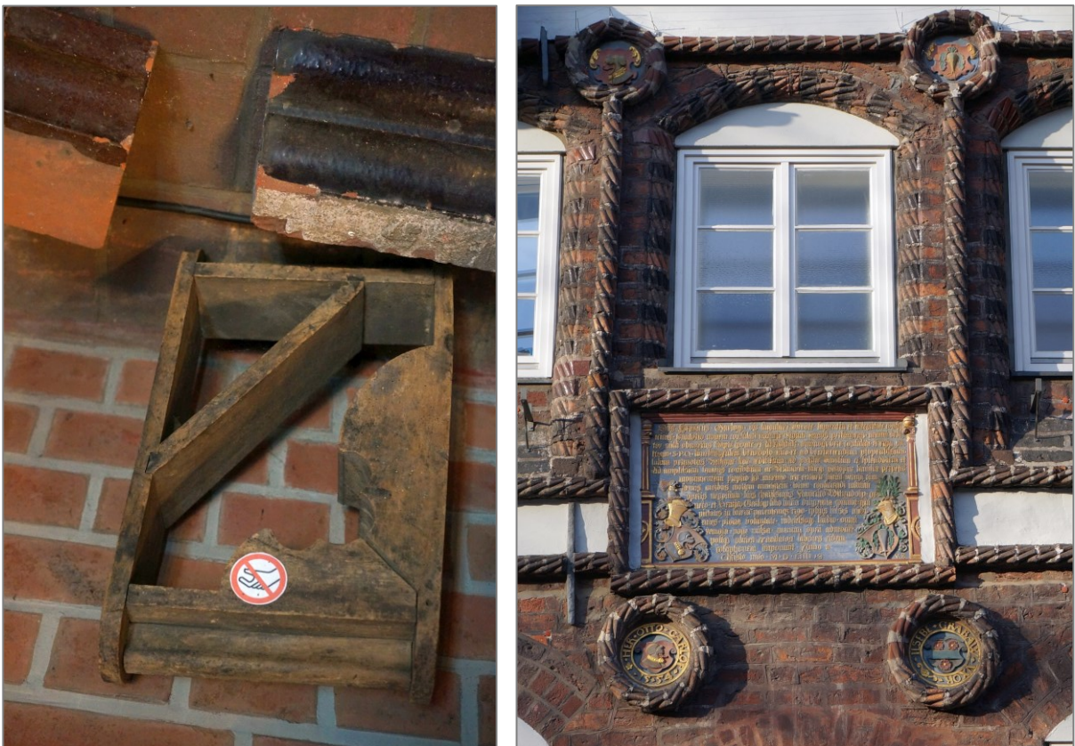
Abbildung 6 Vierpassviertel-Steinform, lüneburger Tau(-werk-)stein. Links: Kleeblatt-Vierpassviertel-Steinform in der Kirche St. Nicolai, rechts: Foto in der Reitende-Diener-Straße, Lüneburg
