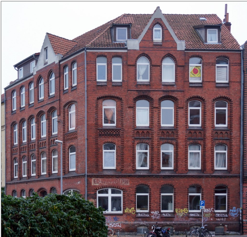
Abbildung 200 Blick aus der Nelkenstraße nach Norden
