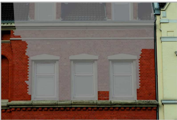
Abbildung 160 Beschädigung Haus Wunder (hellgraue Fläche erneuert) nach optischem Befund
