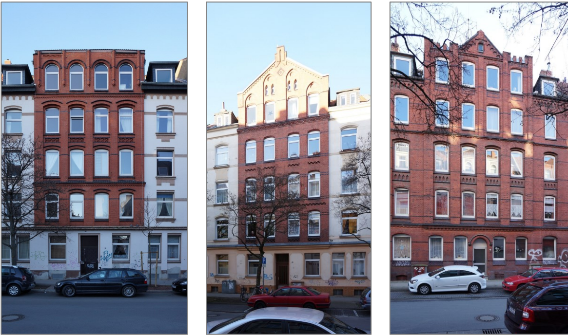
Abbildung 260 Zustand Noltestraße 6, Bethlehemstraße 16 und 3
