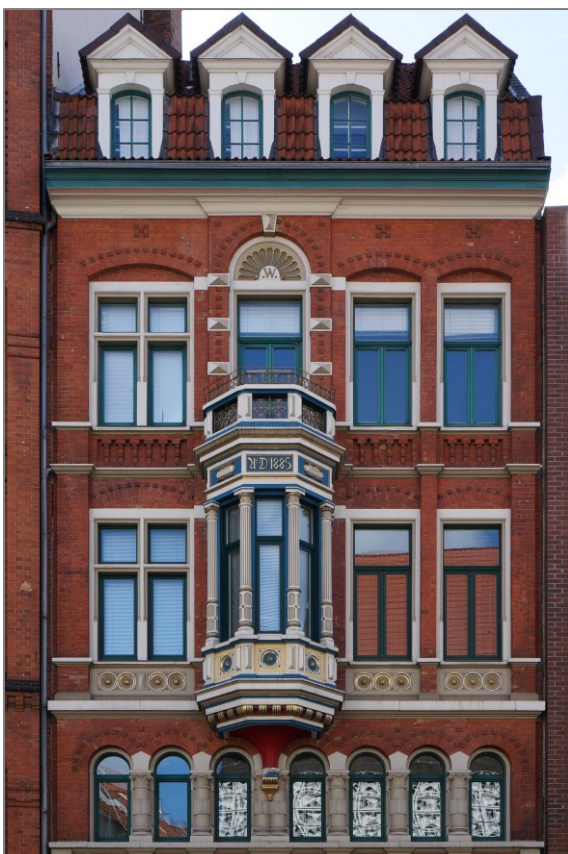
Abbildung 158 Wohn- und Geschäftshaus Eduard Warnebold Schmiedestraße 5 (früher Nr. 22); Foto ab Oberkante des veränderten Erdgeschosses; Gaubenanordnung wohl nicht original
