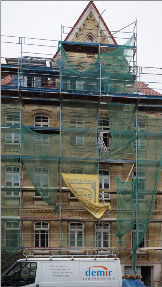
Abbildung 141 Über den Giebel gezogenes Dach "Konsequente Lösung" in der Südstadt, 04 Ifflandstraße 12
