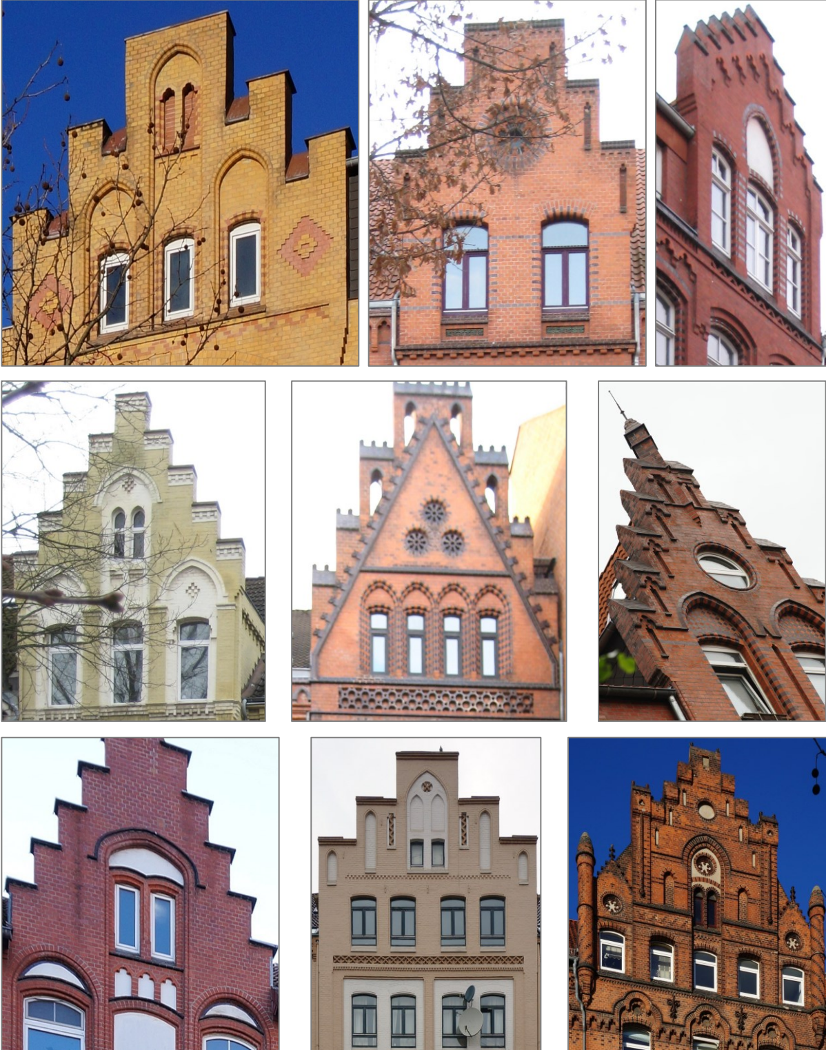
Abbildung 22 Unterschiedliche Treppengiebel 01 Am Klagesmarkt 7A, 03 An der Lutherkirche 12, 03 Heisenstraße 32, 09 Eichstraße 05, 09 Gretchenstraße 45, 33 Wilhelm-Bluhm-Straße 31+33, 34 Deisterstraße. 64, Kompositgiebel am Objekt 01 Am Postkamp 18
