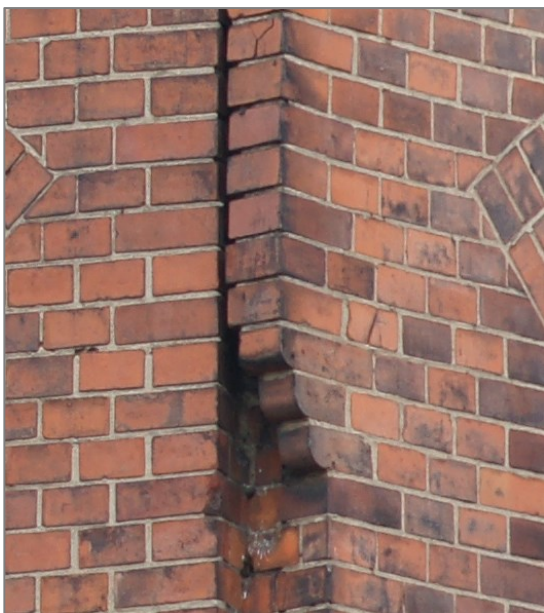
Abbildung 229 Dreifach seitlich auskragende Giebelohren Die viertelrunden Kragsteine waren früher offenbar sowohl als Dreiviertelsteine als auch als halbe vorhanden. Daher wurden sie zur Rekonstruktion der vorkragenden Staffelköpfe vorgesehen
