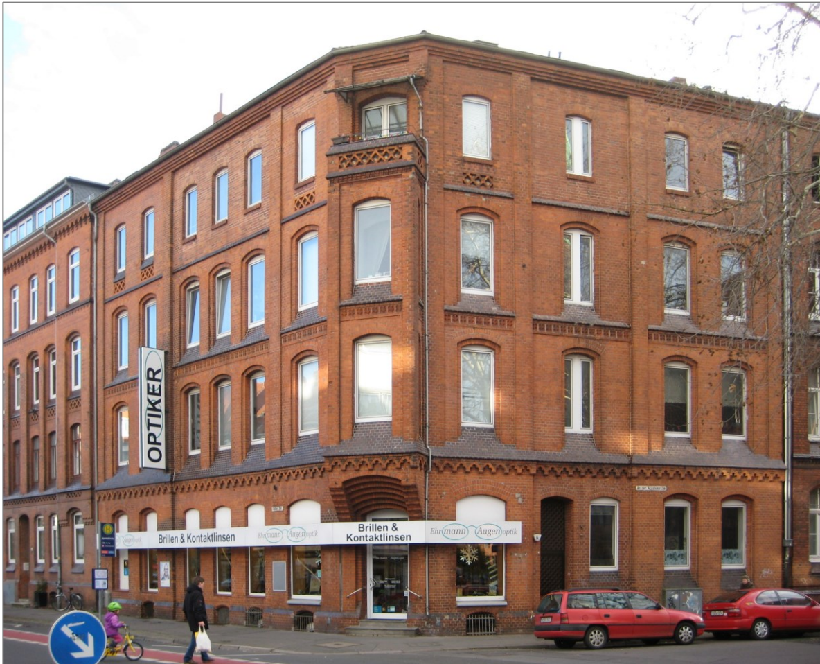
Abbildung 213 Das Eckhaus An der Apostelkirche 4 wurde nachträglich aufgestockt. Dieses Eckhaus vermittelte ursprünglich geschickt zwischen der viergeschossigen Bebauung an der Celler Straße und der niedrigeren, dreigeschossigen an der Straße An der Apostelkirche durch seine Giebel und die Eckbetonung
