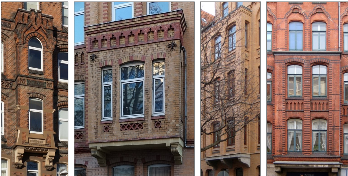
Abbildung 62 Stuckverzierte Stahlträgerkonsolen 01 Postkamp 18 (oder ist es hier doch Naturstein?), 02 Grotefeldstraße 7, 09 Seumestraße 6A, 09 Wedekindstraße 2
