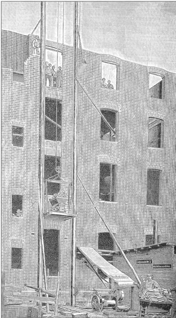
Abbildung 12 Bauen ohne Gerüst
