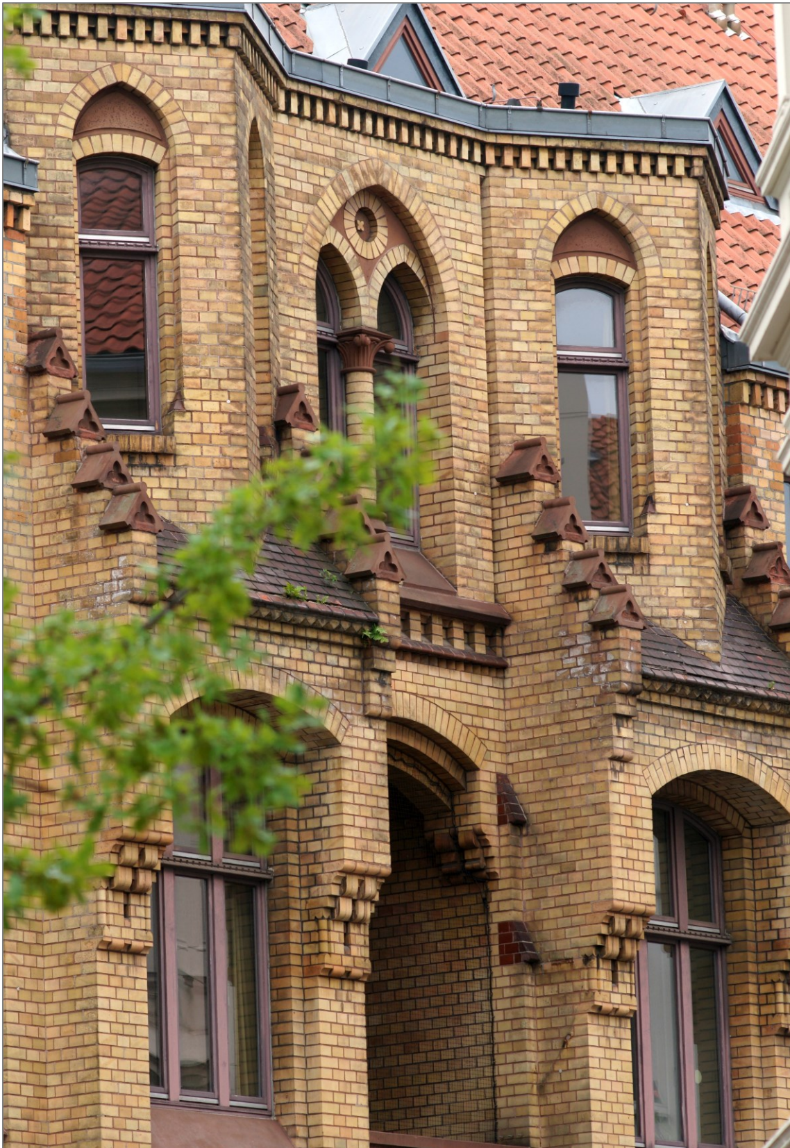
Abbildung 56 Detail des ehemaligen Vincenzstiftes in der 08 Seelhorststraße: gekahlte und gerundete Formsteine sind neben Eckstabsteinen die einzigen Sonderformate dieses Details, Sandsteinverdachungen und ein Terrakottakapitell schmücken die ansonsten robuste Architektur
