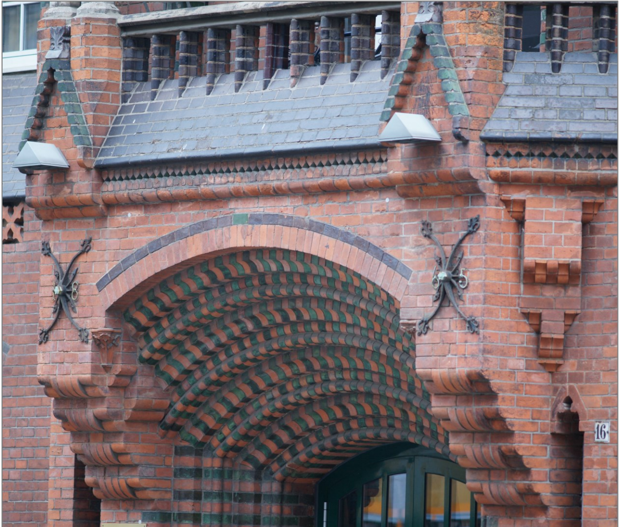
Abbildung 64 Turn-Klubb in der 04 Maschstraße 16, Detail des Balkons über dem Eingang
