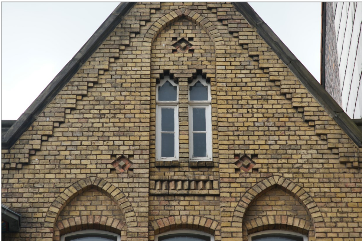
Abbildung 113 Keilförmiger Schlussstein schließt die gotischen Bögen in der 01 Blumenstraße 7. Vgl. auch 09 Lister Meile 29A in Kap. 4.3.1
