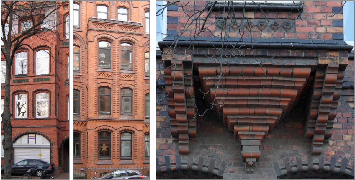
Abbildung 61 Utluchten in der 03 Haltenhoffstraße 36 und der 09 Yorkstraße 8. Ein Erker mit einem schönen Konsolenfuß auf einem Kragstein mit drei Knollen zeigt dieses Haus in der 04 Großen Düwelstraße 15
