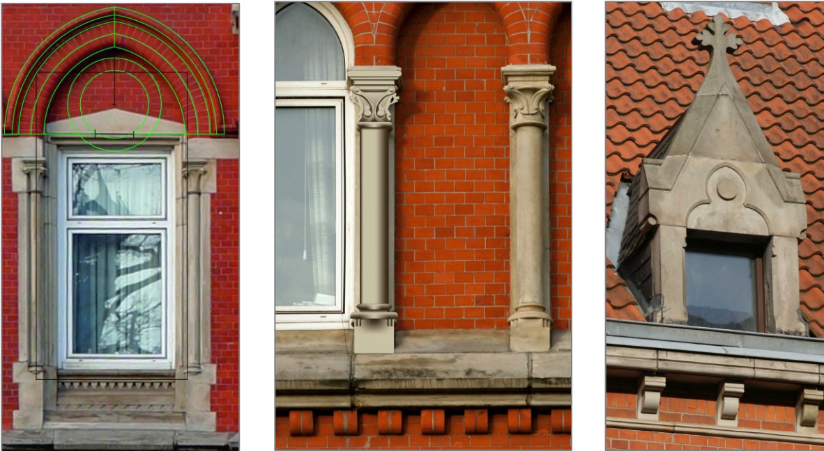
Abbildung 162 Details Haus Wunder links: Ermittlung der Mittelpunkte und Radien des gotischen Blendbogens. Mitte: Sandsteinsäulen der Blendarkade im Galeriegeschoss. Rechts: Gaubenfront aus Sandstein Villa Orgelmann (03 Im Moore 24)
