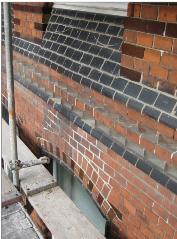
Abbildung 144 Neu eingesetzte Verblendsteine (untere Bildhälfte)
