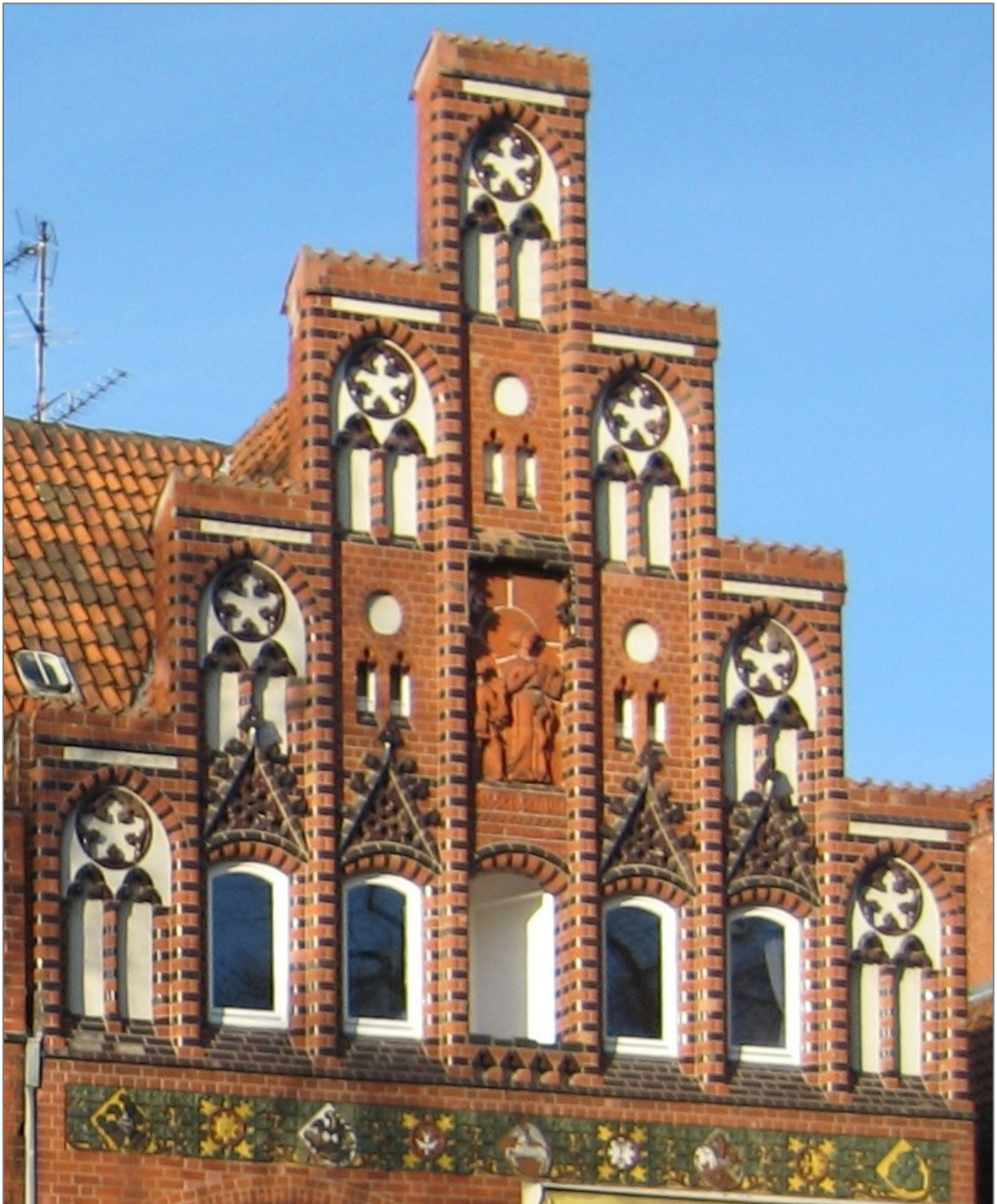
Abbildung 23 Treppengiebel Wohnhaus Mohrmann 03 Herrenhäuser Kirchweg 11 / Reinholdstr. 5. Eine Abbildung von ca. 1913 findet sich in Kokkelink, et al., 1998 S. 135
