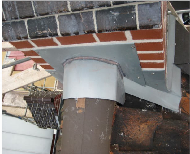
Abbildung 146 Wiederhergestelltes Mitteltürmchen Abbildung 147 (rechts) Rückseitige Blechabdeckung des Mitteltürmchens
