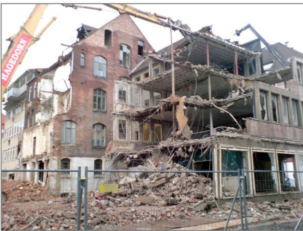
Abbildung 179 Linke Grenzwand während der Abbrucharbeiten. Quelle wie Abbildung 174, Dateiname: 91w5-1fr-e9b7.jpg, aufgerufen am 10.10.2016
