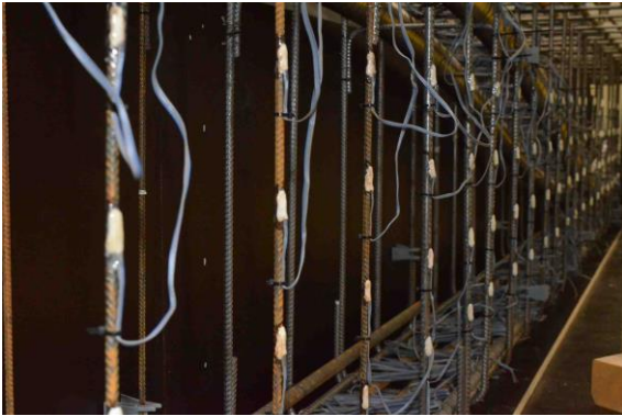
Bild A 1-19: DMS auf Querkraftbewehrung
