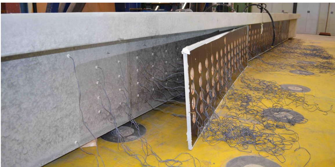
Bild A 1-22: Demontage der doppelten Schalplatte
