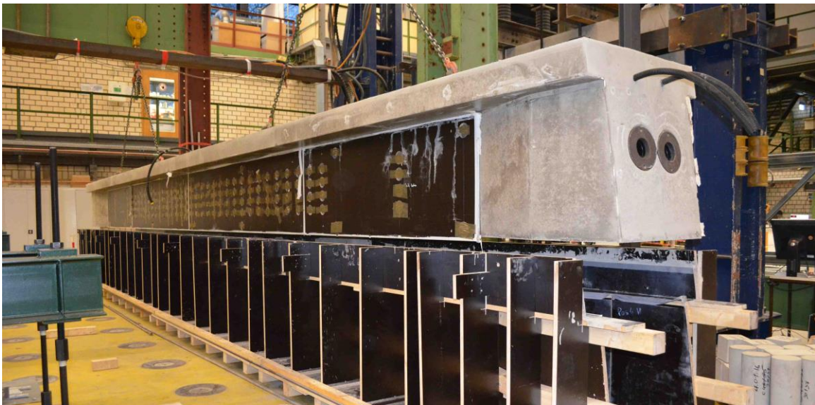
Bild A 1-21: Ausheben eines Versuchsträgers aus der Schalung, DMS-Kabel in gefrästen Nischen der am Träger montierten doppelten Schalplatte eingelegt
