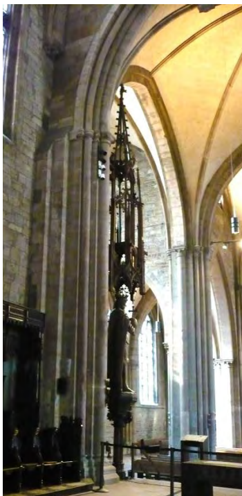
Abb. 9 – Baunaht südöstlicher Vierungspfeiler. Standort Chor. Blick Richtung Vierung. Stützelemente erscheinen als zwei parallelstehende eckige Wandpfeiler der Scheidwand zur Vierung. (© ak)
