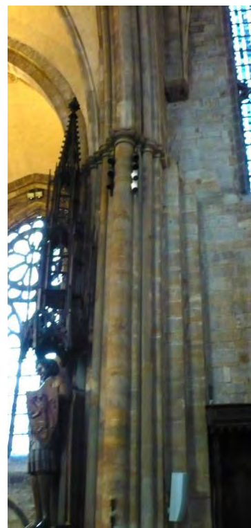
Abb. 7 a-b – Baunaht Vierungspfeiler. Standort unter dem Triumphbogen. Blick Übergang Vierungspfeilerschaft in den Bogen. Der Triumphbogen als Scheidbogen zwischen Vierung und Chor tritt im Bündelpfeilerschaft als ein alter Dienst flankiert von zwei jungen Diensten in Erscheinung. (© ak)
