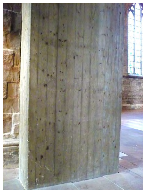
Abb. 22-23 – Banahturm: Blick auf beide Stützen. Diese erscheinen aufgrund der Farbe holzverkleidet, sind aber weder aus Holz gefertigt noch mit Holzlatten verkleidet. (© ak)
