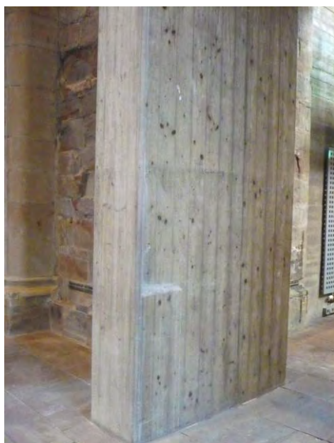
Abb. 22-23 – Banahturm: Blick auf beide Stützen. Diese erscheinen aufgrund der Farbe holzverkleidet, sind aber weder aus Holz gefertigt noch mit Holzlatten verkleidet. (© ak)
