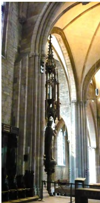
Abb. 11 – Baunaht südöstlicher Vierungspfeiler. Blick auf Scheidwand. Die Pfeilerstützen erscheinen abgetreppt. (© ak)
