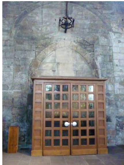
Abb. 28 a / b – Bauveränderungen des Querhausportals. Standort nördliches Querhaus. Blick auf südliches Querhausportal mit ausschließlich sichtbaren Veränderungen der Portalform. (© av / ak)
