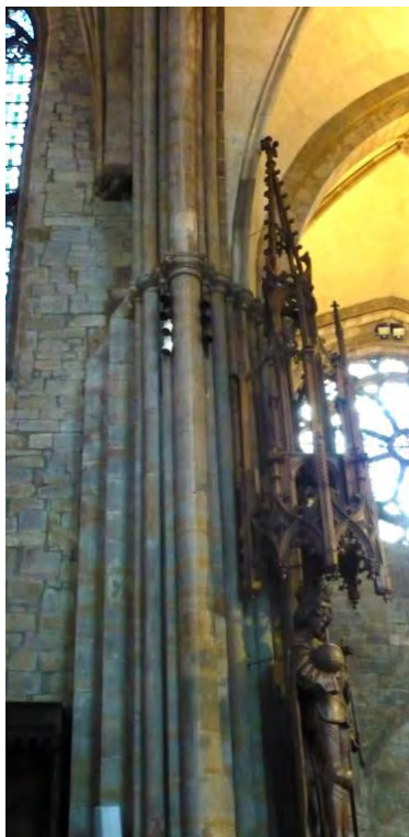
Abb. 7 a-b – Baunaht Vierungspfeiler. Standort unter dem Triumphbogen. Blick Übergang Vierungspfeilerschaft in den Bogen. Der Triumphbogen als Scheidbogen zwischen Vierung und Chor tritt im Bündelpfeilerschaft als ein alter Dienst flankiert von zwei jungen Diensten in Erscheinung. (© ak)
