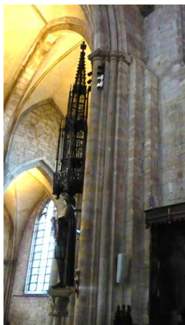
Abb. 12 – Baunaht nordöstlicher Vierungspfeiler. Blick auf Scheidwand. Die an der Scheidwand zur Vierung ansetzende Pfeilerkomponente überlagert die an der Schildwand angrenzende abgetreppt. (© ak)
