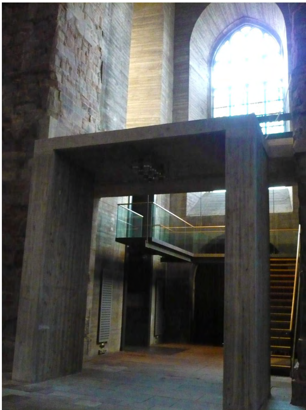
Abb. 16 – Baunaht Turm. Standort Mittelschiff. Blick in den Turm ist barrierefrei ohne Glastür aufgrund ausgebauter Orgel möglich (25. Februar 2020). Die innen liegende Betonverschalung kontrastiert mit den Hausteinen des Kirchenschiffs ebenso wie die betongegossenen Orgelstützen. (© ak)
