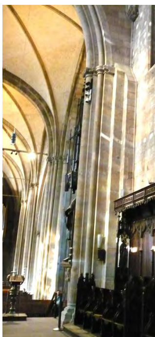
Abb. 10 – Baunaht nordöstlicher Vierungspfeiler. Standort Chor. Blick Richtung Vierung. Stützelemente identisch mit südöstlichem Vierungspfeiler. (© ak)
