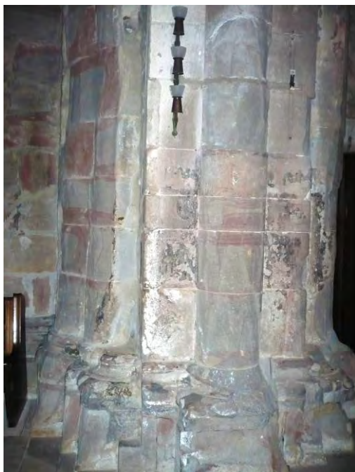
Abb. 25 b / c – Bauwerknarbe nordwestlichen Wandpfeiler. Standort erstes Joch des nördlichen Seitenschiffs mit Blick auf Basis (links) und Blick auf Kapitell (rechts). (© ak / fb)
