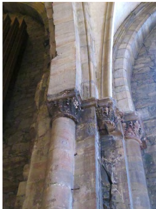
Abb. 25 b / c – Bauwerknarbe nordwestlichen Wandpfeiler. Standort erstes Joch des nördlichen Seitenschiffs mit Blick auf Basis (links) und Blick auf Kapitell (rechts). (© ak / fb)
