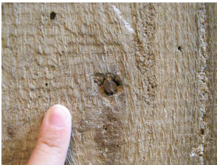
Abb. 24 b – Baunaht Turm. Blick auf südliche Orgelstütze. Ein herausgebrochener Bereich an einem Stahlstift belegt, dass die Stützen nicht aus Holz gefertigt sind. (© fb)
