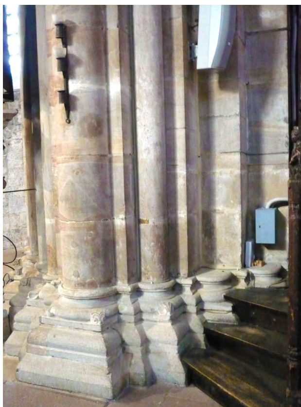
Abb. 6 – Baunaht nordöstlicher Vierungspfeiler. Basis. Entsprechende Taststellen, jedoch mit störendem Elektronikschaltkasten. (© ak)
