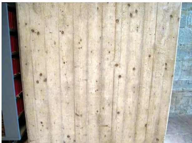
Abb. 24 a – Baunaht Turm. Blick auf südliche Orgelstütze. (© fb)
