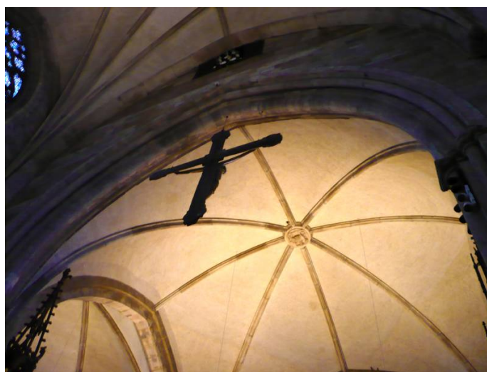
Abb. 8 – Baunaht Vierungspfeiler. Blick auf den spitzbogigen Triumphbogen zum Triumphkreuz. Seine Laibung wird durch einen Scheidbogen und zwei Ortbögen gebildet. (© ak)
