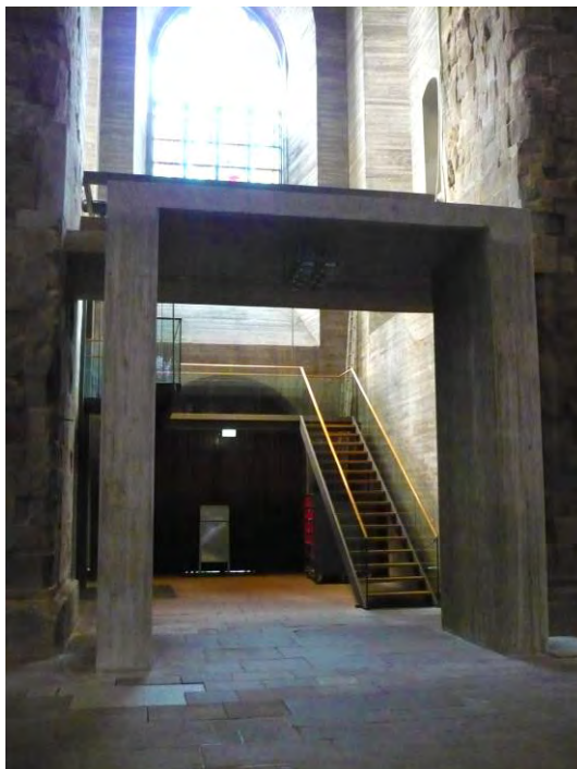
Abb. 21 – Banahturm. Betonstützen der später eingebauten Orgel bieten Tasteindrücke des Materials Beton . (© ak)
