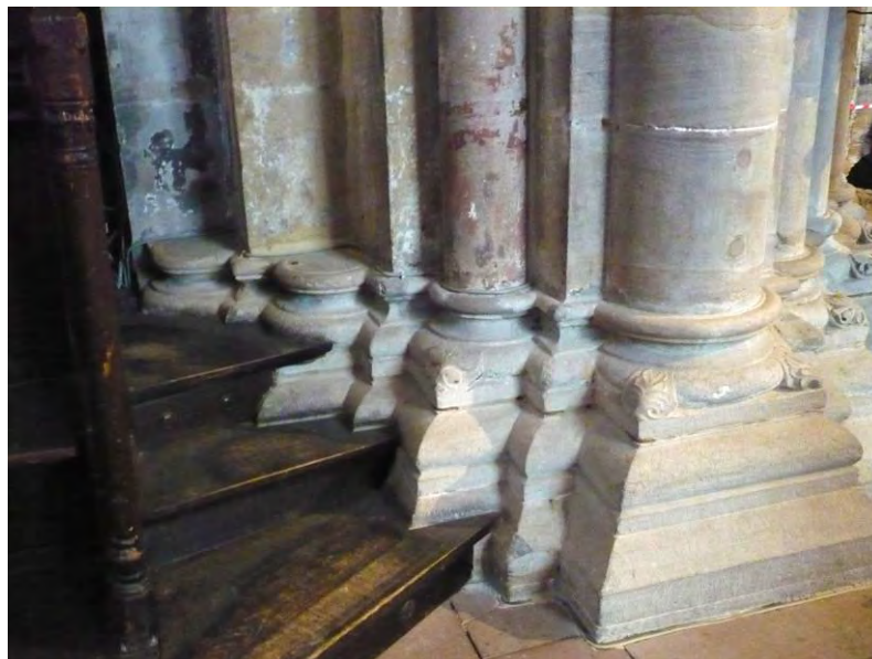
Abb. 14 – Baunaht südöstlicher Vierungspfeiler. Basis. Die steinerne Naht leitet in das festinstallierte hölzerne Chorgestühl über. (© ak)
