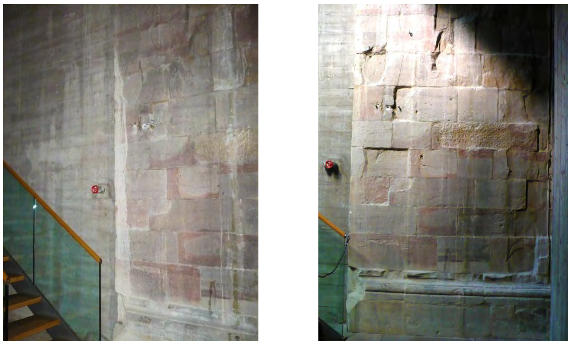
Abb. 17 a-b – Baunaht Turm. Blick auf Nordwand. Die Naht besteht aus einer sauber gearbeiteten Fuge am östlichen Ende des eigentlichen Turms. (© ak)
