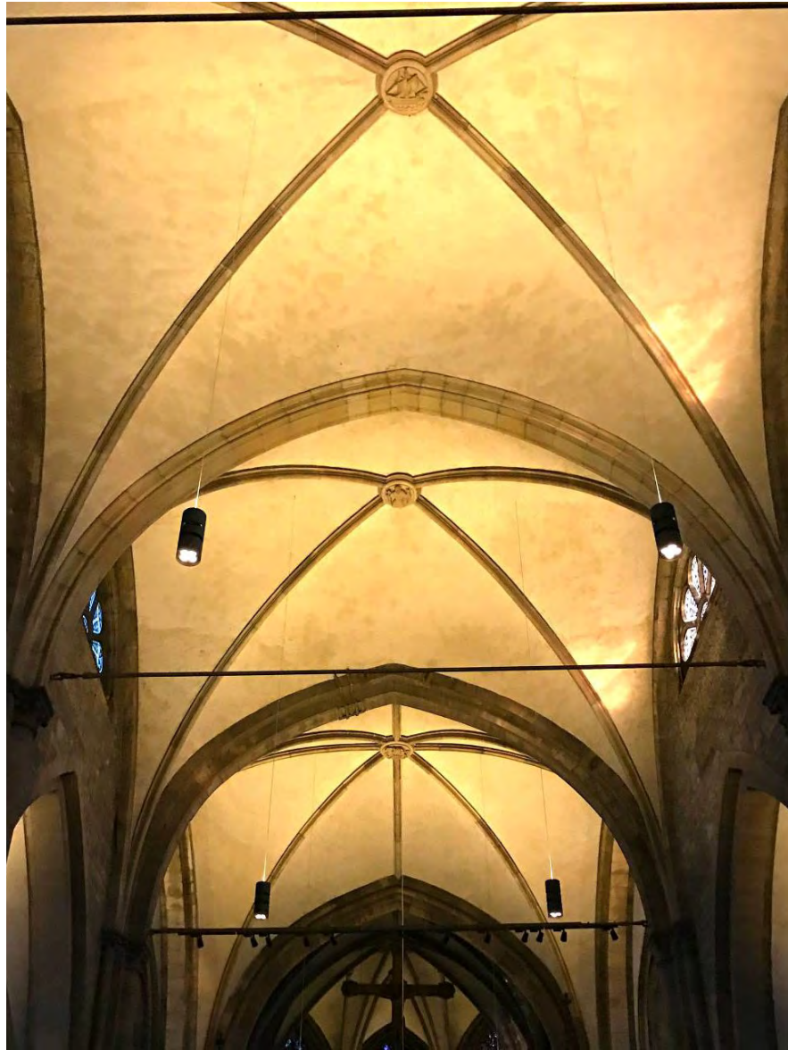
Abb. 4 – Standort zweites Mittelschiffjoch. Blick in die Gewölbezone Richtung Chor zur Visualisierung der Bedeutungszunahme durch die drei Gewölbeformen im Lang- und Querhaus, in der Vierung und im Chor. (© av)
