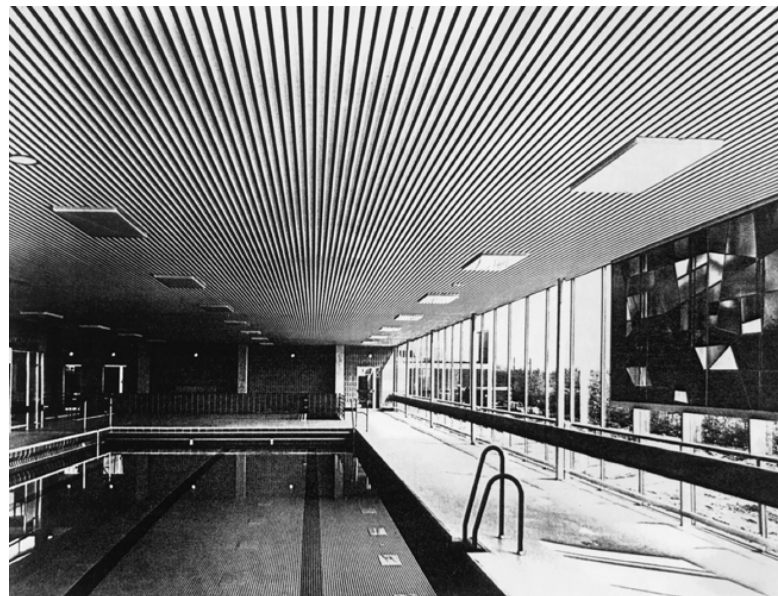
Abb. 6.69: P. F. Schneider, Gartenbad Castrop-Rauxel, Lehrschwimmbecken mit Farbmosaik in Blautönen von Otto Korn, um 1963 (Foto: Inge von der Ropp, HASTK Bestand 1360, A 24, © HASTK)
