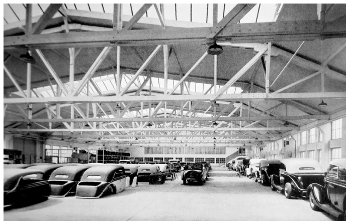
Abb. 3.18: P. F. Schneider, Karosseriewerk Deutsch, Köln, Montagehalle (aus: Moderne Bauformen , 1941, H. 9, S. 391)
