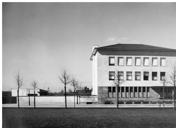
Abb. 6.6 Edmund Körner, Verwaltungsbau der Continental-Gummiwerke AG Köln, um 1931 (Foto: Baukunstarchiv NRW, Bestand Edmund Körner im Bestand Peter Grund)
