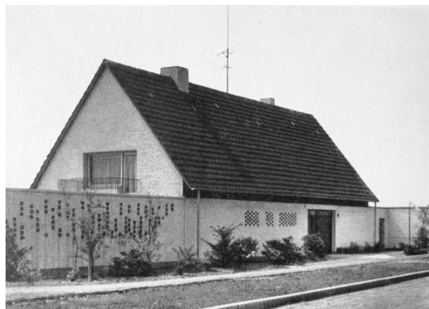
Abb. 6.37: P. F. Schneider, Haus Funke (aus: Architektur und Wohnform , 1955/56, Heft 5, S. 175)
