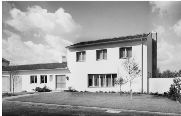
Abb.: 6.7: Haus P. F. Schneider, Köln-Rodenkirchen, um 1951 (aus: Architektur und Wohnform , 1950/51, Heft 3, S. 73)
