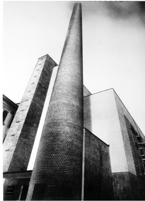
Abb. 6.35: Behrens/Popp, Kesselhaus der Linzer Zigarettenfabrik (aus: Kai Mühlmann, Die Neubauten und Betriebseinrichtungen der Tabakfabrik Linz , Salzburg 1936, o. S.)
