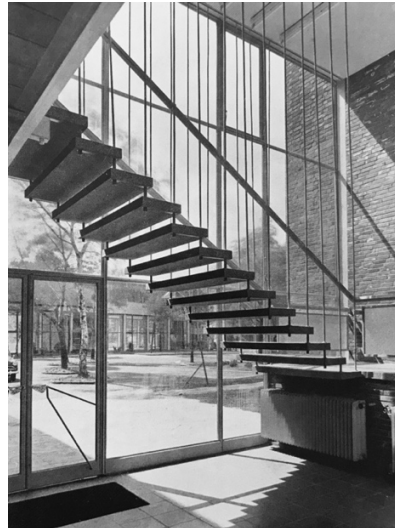
Abb. 6.20: P. F. Schneider, Sportschule des Westdeutschen Fußballverbandes, Treppenhaus zwischen Unterkunftsgebäude und Verwaltung (aus: Baumeister , 1956, Heft 6, S. 384)
