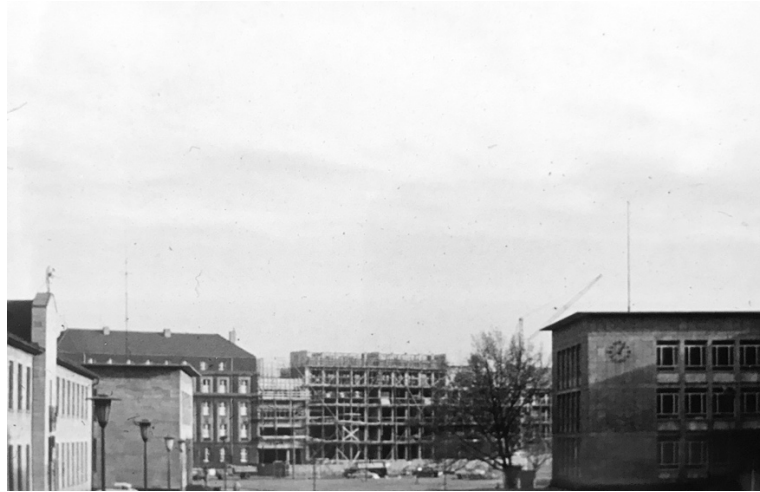
Abb. 6.47: P. F. Schneider, Gesundheitsamt Essen (mit Baugerüst), Blickachse von der Kettwiger Straße über den Burgplatz, um 1960 (Foto Privatarchiv Hans Petzold)
