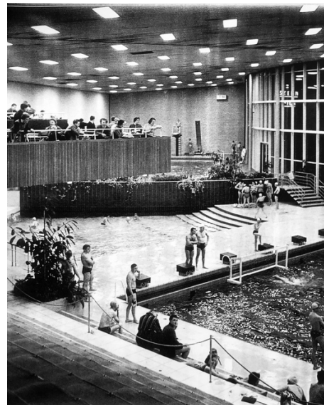
Abb. 6.54: P. F. Schneider, Hauptbad Essen: links oben Kanzel der Milchbar, im Hintergrund das erhöht liegende Mehrzweckbecken mit Pflanzmauer (aus: Stadt Essen, Essen im Objektiv , Essen o.J., o. S.)
