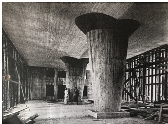
Abb. 4.3: P. F. Schneider, Funkhaus des NWDR, sogenannte „Pilzstützen“ des Technikflügels (aus: Bauen und Wohnen , 5. Jg. 1950, Heft 8, S. 440)
