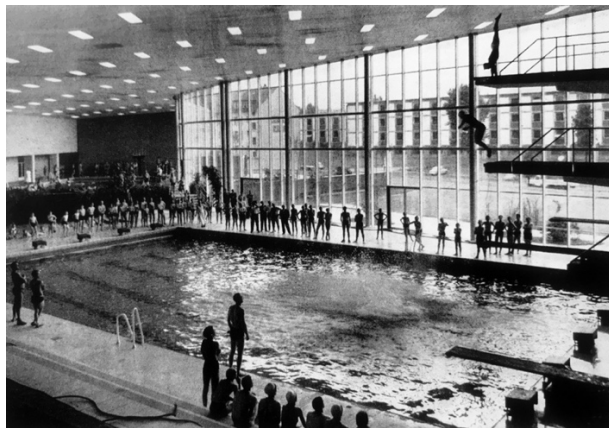
Abb. 6.57: P. F. Schneider, Hauptbad Essen: Schwimmhalle (aus: Baukunst und Werkform , 1960, Heft 9, S. 489)
