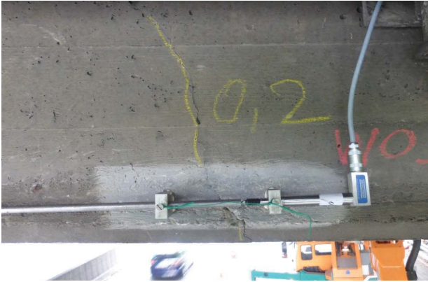
Abb. 6.14.: Induktiver Wegaufnehmer an einer Messstelle am Bauwerk
