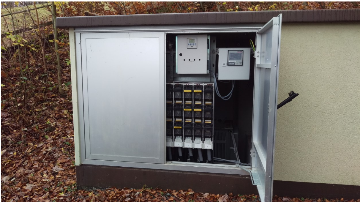
Abbildung 5.28: Ortsnetzstation ONS
