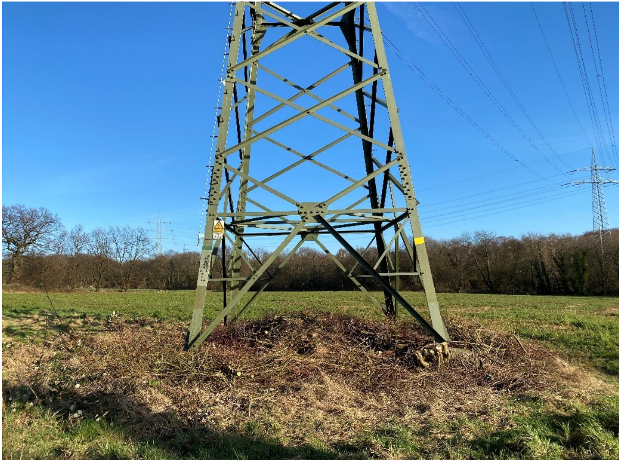
Abbildung 81 Freischnitt Mastfuß 110-kV Leitung Eppendorf - Hattingen, BI.1797, Mast W1
