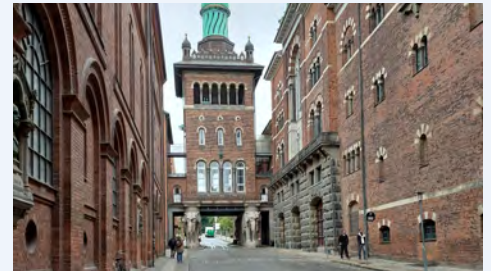
Alte Gebäudesubstanz im Ny Carlsberg Vej
