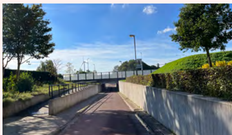
Unterführung der Doorfietsroute Houten – Leidsche Rijn
