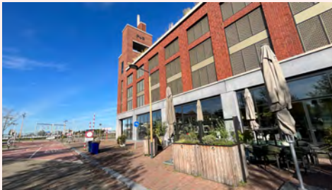
Gastronomische Erdgeschossnutzung im P+R-Parkhaus an der Berlinlijn
