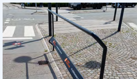
Haltegriff bzw. Trittstütze an einer Ampel an der Fahrradautobahn C91
