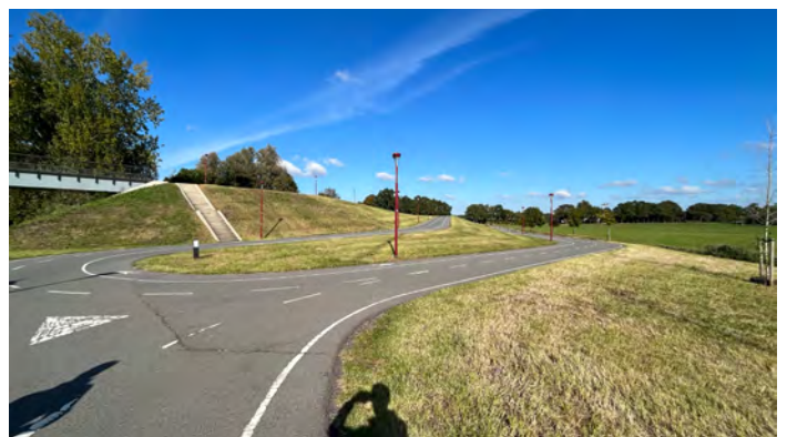
Abb. 23: Rampenanlage an der Nieuwe Heemstedebrug südlich von Utrecht (Eigene Darstellung)
