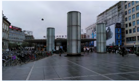
Lüftungsschächte an der Station Nørreport
