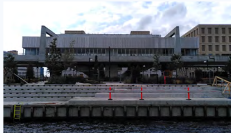
Frontansicht auf die Metrostation Orientkaj
