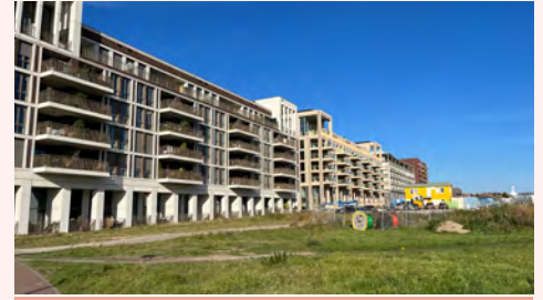
Moderner, hochgeschossiger Wohnungsneubau in der Madridstraat
