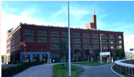
Dachbegrünung auf dem P+R-Parkhaus an der Berlinlijn
