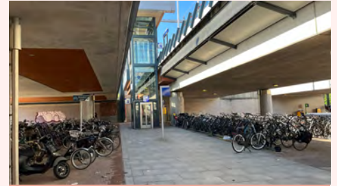
Zugang zu den beiden oberirdisch geführten Bahnsteigen am Bahnhof Leidsche Rijn
