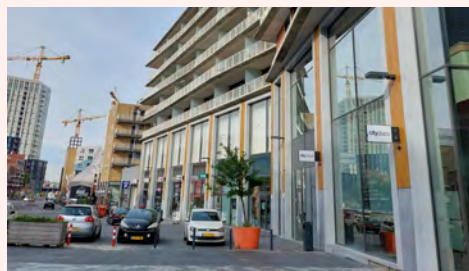
Kurzzeitparken im Straßenraum und Zugang zu einer Tiefgarage in Nieuwegein
