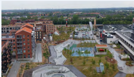
Freiraumgestaltung angrenzend an das Einkaufszentrum City 2
