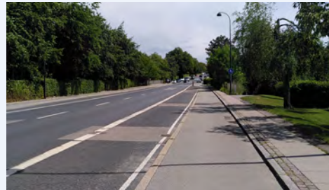
Wegeführung des C91 entlang einer Landstraße
