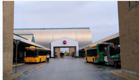
Bahnhofsgebäude Høje Taastrup mit Vorplatz
