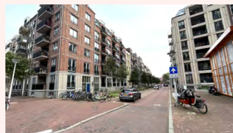
Fahrrad-Abstellanlagen an einem Wohnhaus am Jongeneelwerf
