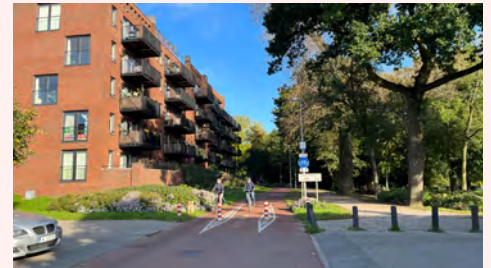
Übergang von Fahrradstraße in Zweirichtungradweg | Everard Meijsterlaan, Park Oog in AI
