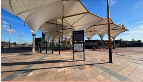
Fächerartige Überdachung der Bussteige am Bahnhof Leidsche Rijn
