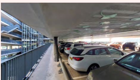
Parkende Autos in Obergeschoss des P+R Parkhauses Science Park
