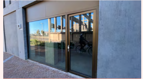
Zugang zu ebenerdigen Fahrradstellplätzen im Erdgeschoss
