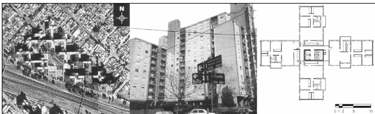
Abbildung 39 Wohnanlage Cardenal Copello – 1984
