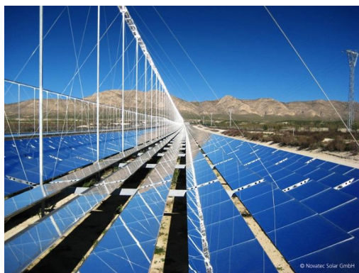
Abb. 1: links: Solarfeld eines Fresnelsolarkraftwerks (Quelle: Novatec Solar GmbH); rechts: Modell eines Solarfeldes eines Fresnelsolarkraftwerks
