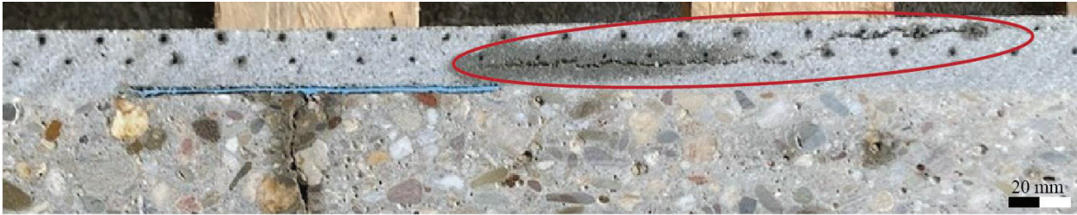
Bild 6-13: Rissüberbrückungsprobekörper II mit Fehlstelle im Textilbeton (rote Ellipse)
