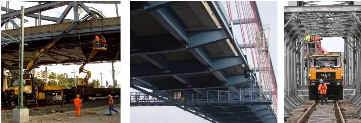
Abb. 2.4: Brückenhauptprüfungen (H) mit Hilfsmitteln wie Hub- (l. [257] u r. [277]) und Teleskopsteiger (l.) bzw. stationärem Besichtigungswagen (m. [250])
