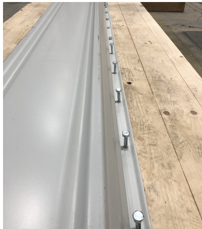
Bild C.15: Festziehen von der Mitte zum Rand
