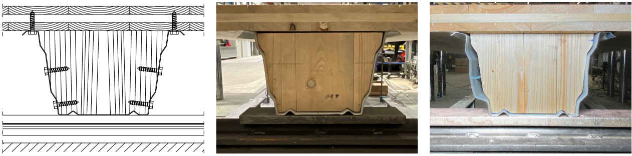
Bild 4.38: Auflagersituation, Ausgangs- und Endzustand für B-HS10-90-02
