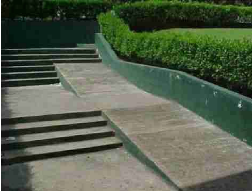
Abbildung 1 Barrierearme Treppe (Goorwich 2014)
