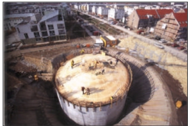
Abb. 14: Langzeitwärmespeicher (2.750 m 3 ) im Bau
