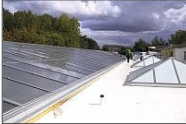
Abb. 42, 43, 44: Wasserkollektor-, Luftkollektor- und Solarabsorberfläche des „aquaLaatziums“
