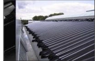
Abb. 42, 43, 44: Wasserkollektor-, Luftkollektor- und Solarabsorberfläche des „aquaLaatziums“
