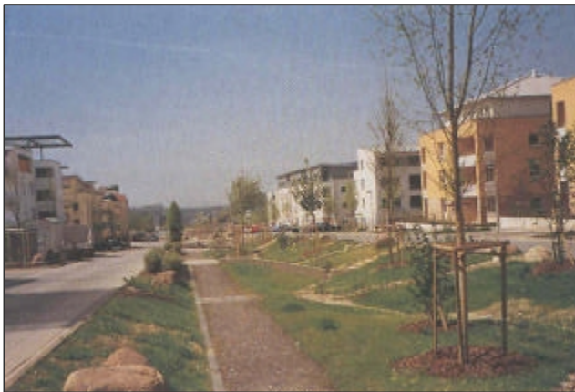
Abb. 15: Das Mulden-Rigolen-System im öffentlichen Straßenraum
