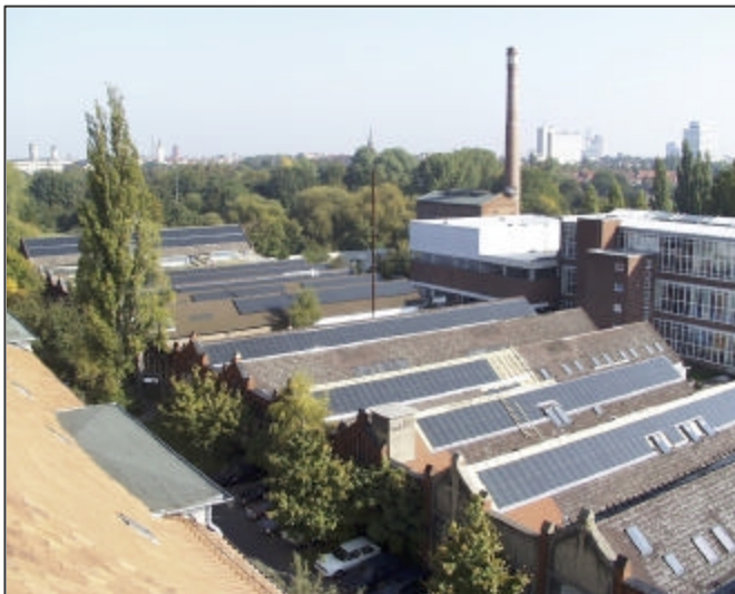
Abb. 47: Photovoltaikanlage auf dem Dach der Ökologischen Gewerbehof Linden GmbH
