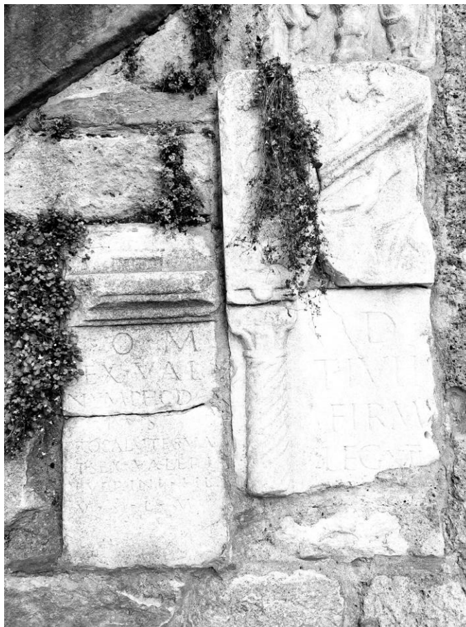
Abb. 5_12_001: Wiederverwendung von antiken Bauelementen in mittelalterlichen Bauwerken in Ptuj, Slowenien
