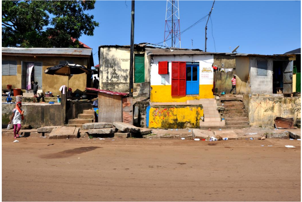
Abb. 2_1_3_012: Vernakuläre Architektur in Conakry, Guinea
