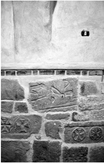
Abb. 2_2_3_006: Wiederverwendung von antikem Baumaterial im Koptischen Kloster am Westufer des Nils bei Qurna
