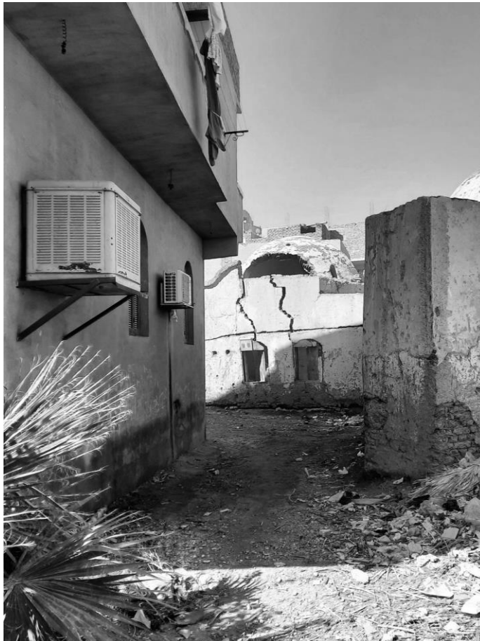
Abb. 5_12_002: Nebenstraße in New Qurna mit zerstörtem Lehmgebäude
