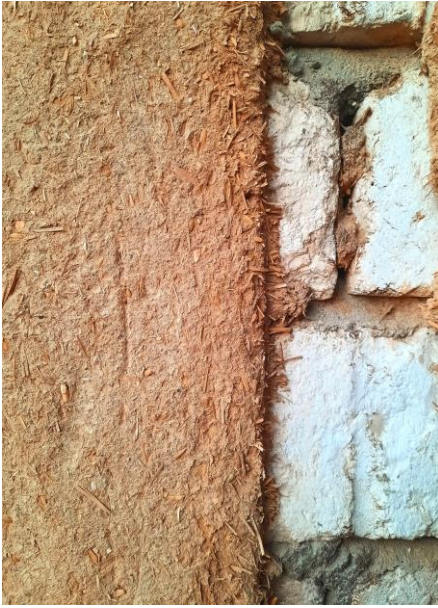
Abb. 5_10_002: Wohnhaus in der Nähe von Qurna: Detailsicht der Wandkonstruktion
