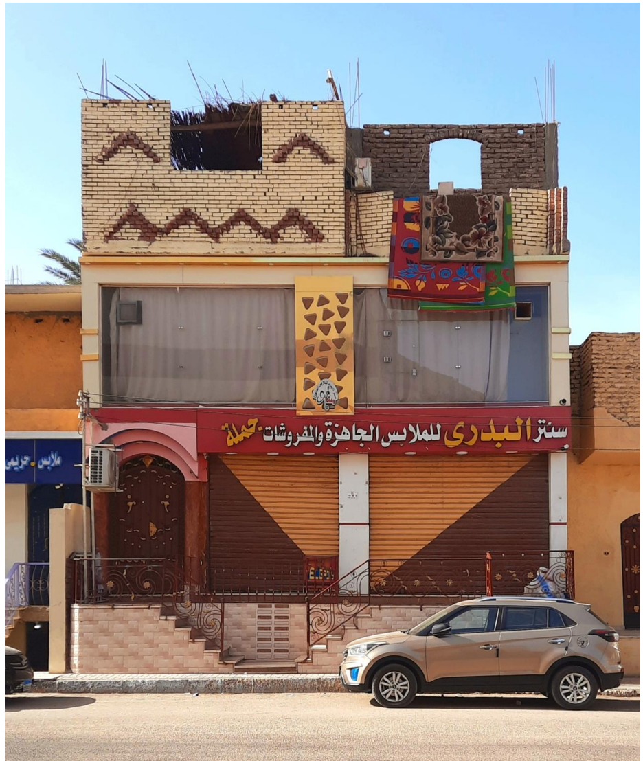
Abb. 5_7_003: Straßenfassaden in New Qurna
