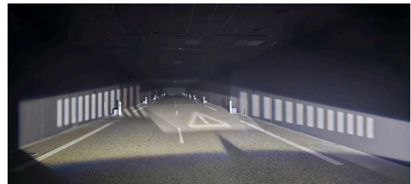
(d) Warning sign.
