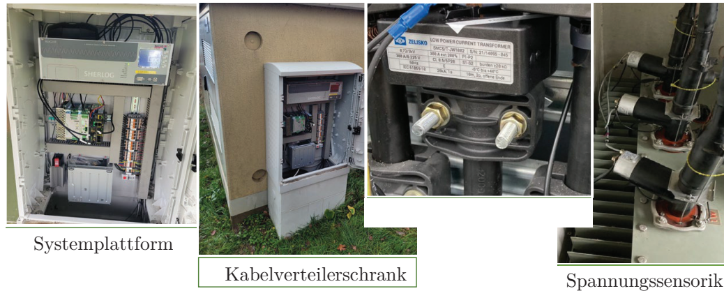
Abb. 5.27: Einbau der Sekundärtechnik im 10-kV-Mittelspannungsnetz
