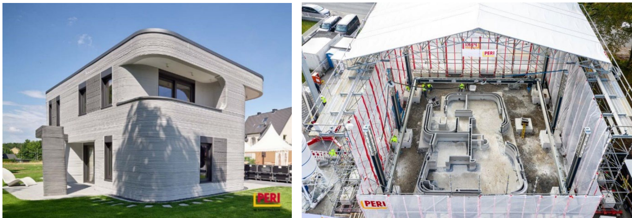
Abb. 12: Herstellungsaufbau des ersten 3-D gedruckten Hauses in Deutschland, Beckum
