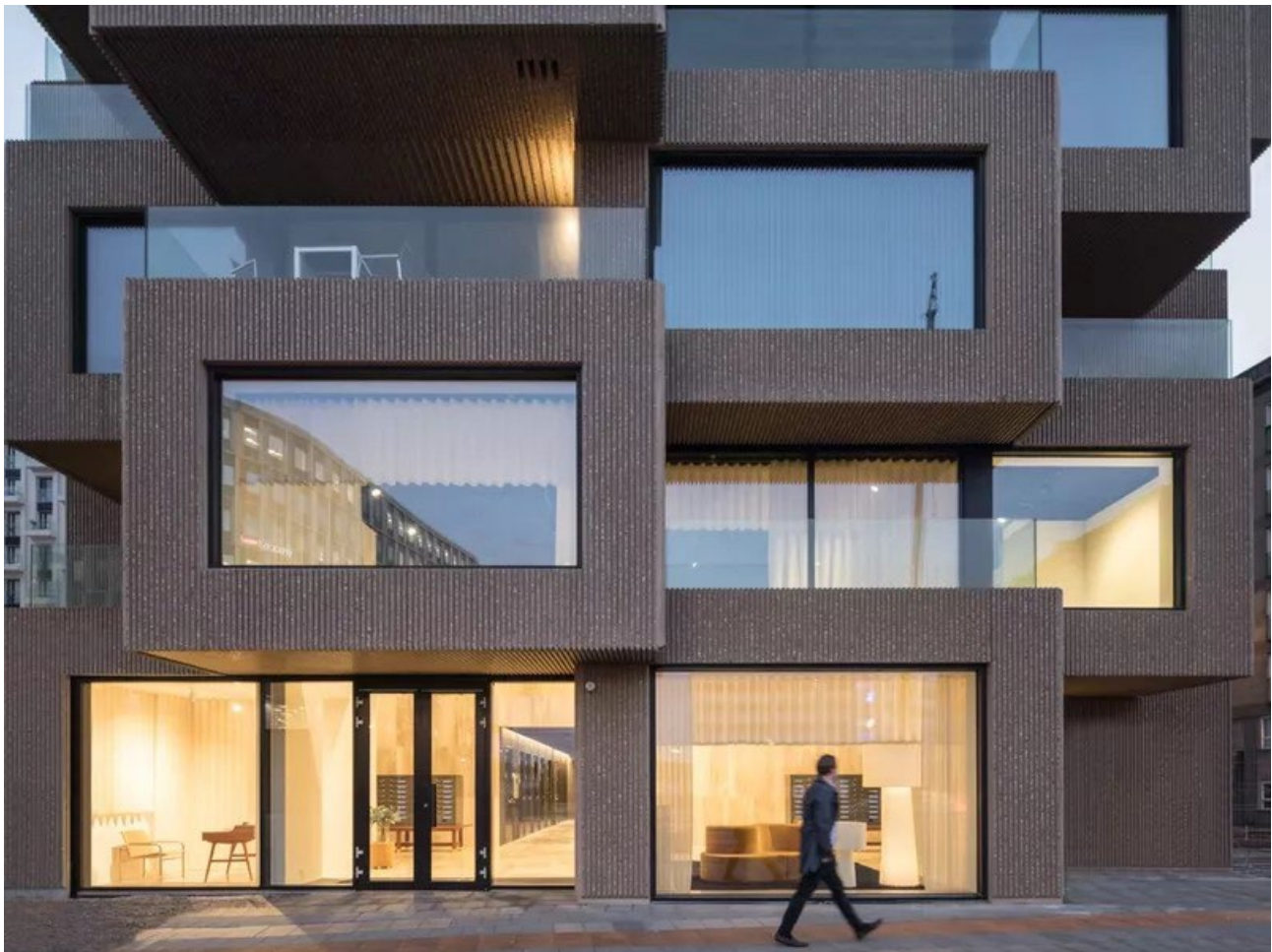
Abb. 26: Wohnhochhaus in vorgefertigter Betonbauweise, Reinier de Graaf/OMA, Norra Tornen, Stockholm, 2020
