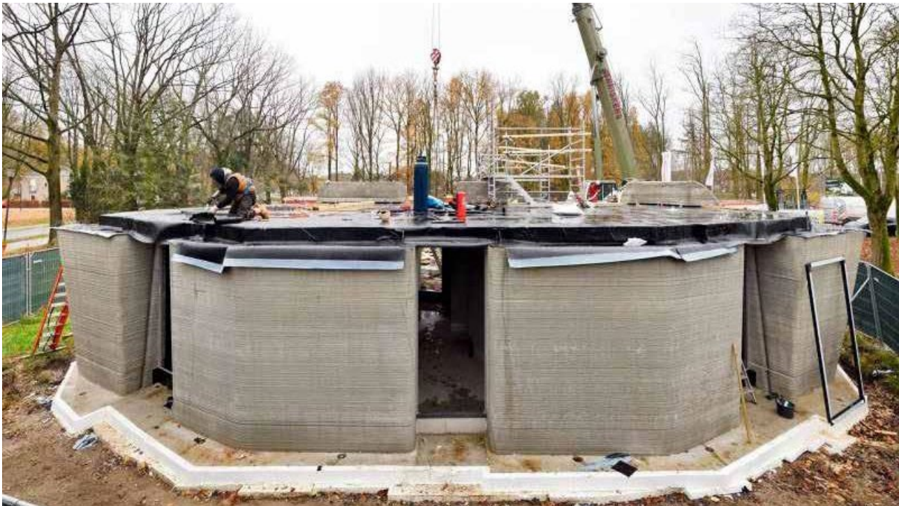
Abb. 14: Montage der vorgefertigten 3-D-Druck Elemente, Milestones © 3dprintedhouse
