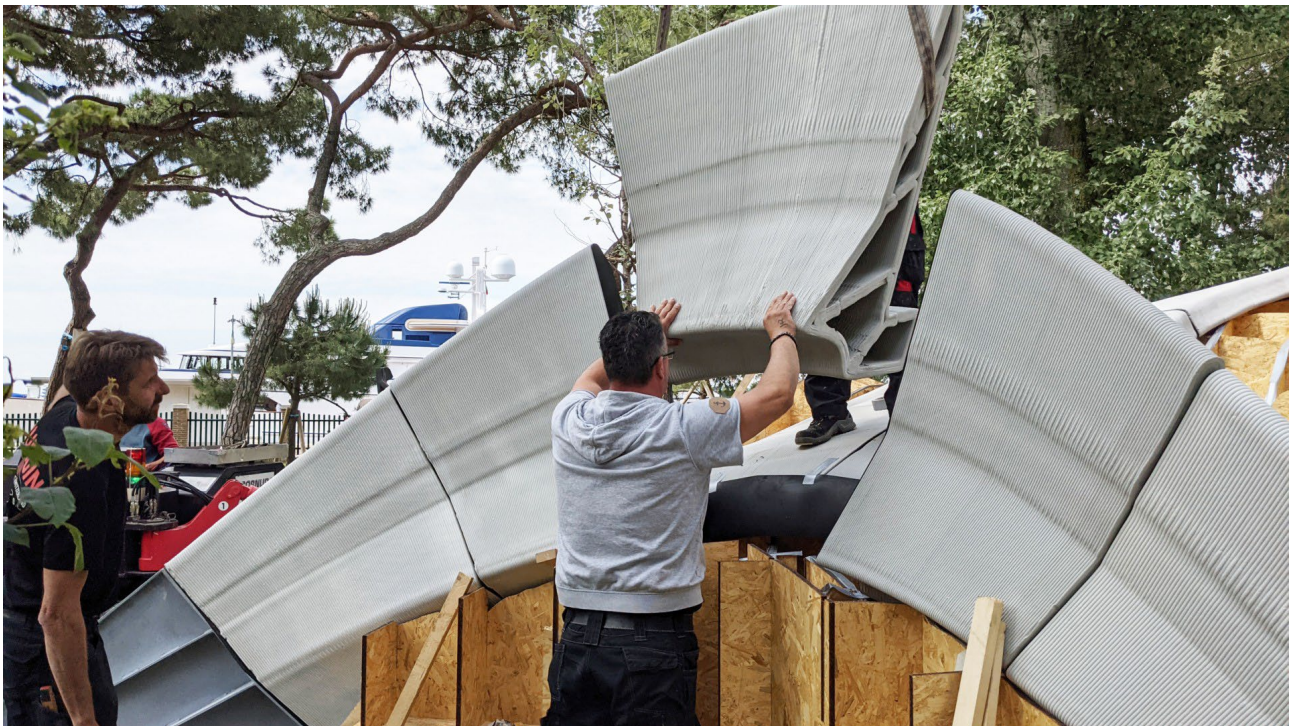
Abb. 13: Modulare Fügung der 3D gedruckten Elemente, Striatus-Brücke, Venedig
