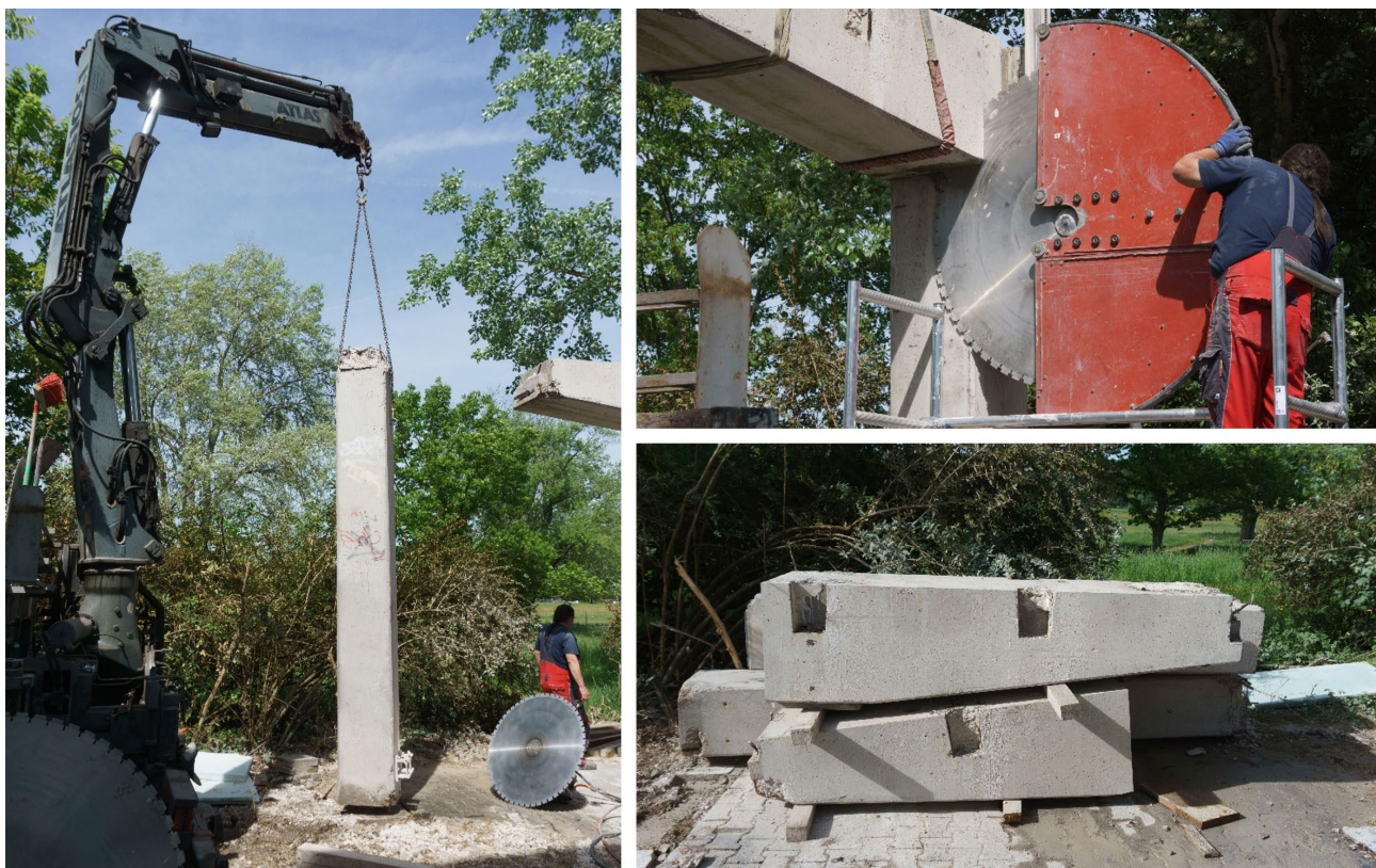
Abb. 35: selektiver Rückbau von Betonkomponenten am Campus Lichtwiese © Malcom Unger, DDU
