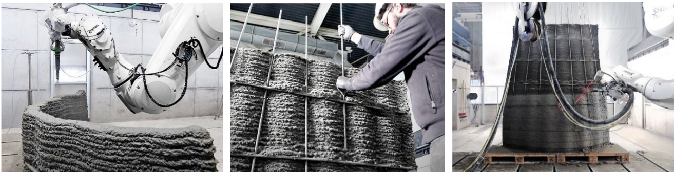
Abb. 15: Kombination von drei Prozessschritten zur Erstellung des Shotcrete Demonstrators
