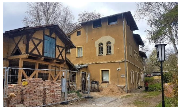
Abb. 35: Altes Pfingsthaus mit Nebengebäude (Stall- und Abtrittgebäude). Eigene Aufnahme 10.04.2021.
