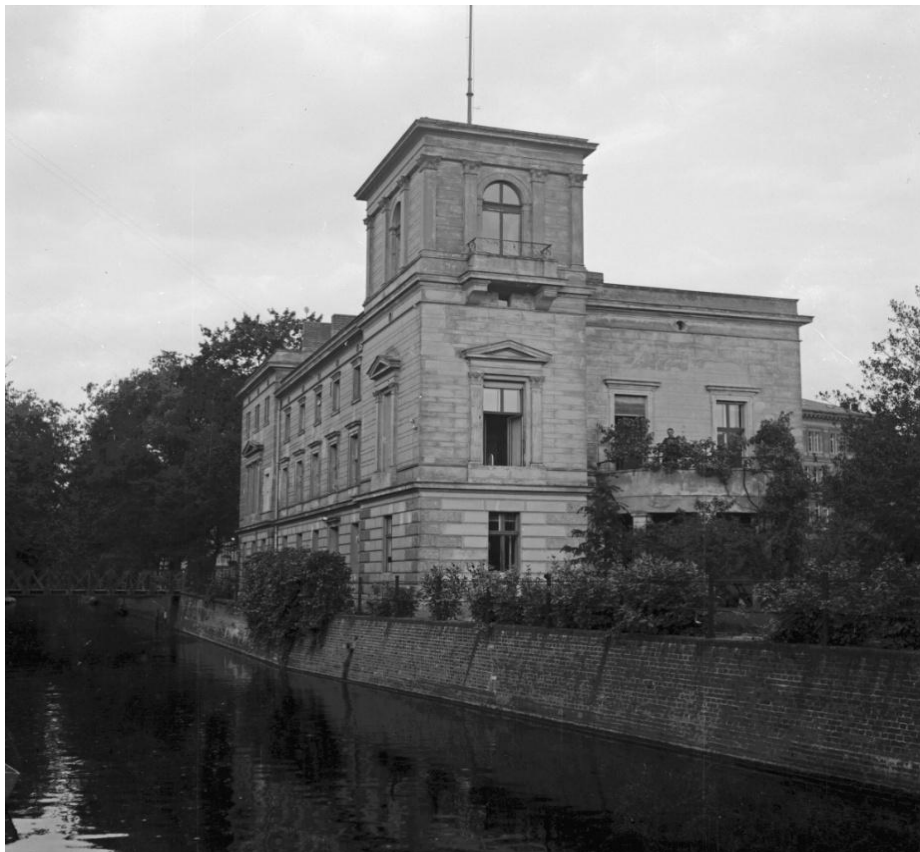
Abb. 73: Villa Hoffbauer (Südfassade mit Turm), An der Gewehrfabrik 6, aufgenommen am 13.09.1938.
