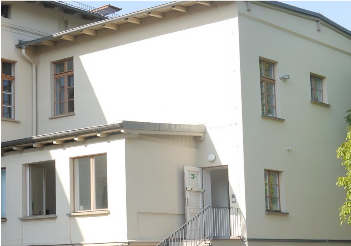
Abb. 14: Eigene Aufnahme von 26.09.2018. Der 1896 errichtete Anbau am Zivilwaisenhaus mit umgebauter Veranda.
