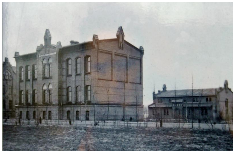
Abb. 87: Schule - Haus Erle (vorne) - und Turnhalle (hinten), um 1901. Beide Gebäude wurden im Zweiten Weltkrieg zerstört und nicht wieder aufgebaut.
