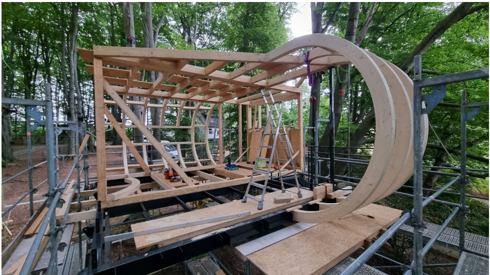
Abbildung 110: Errichtung des Baukörpers auf einem Traggerüst ca. 3 m über Grund.
