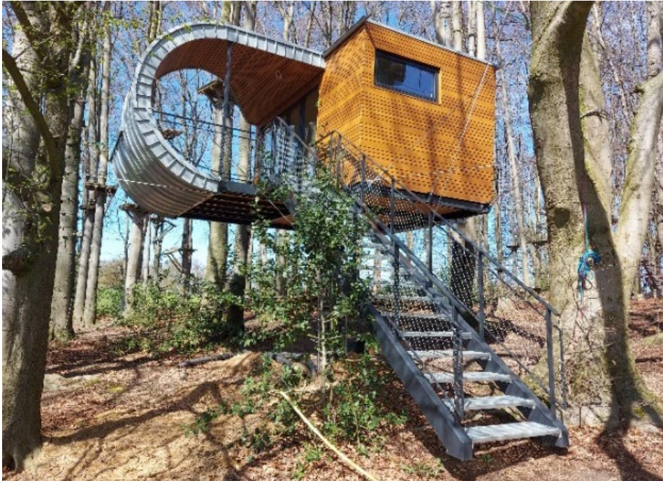
Abbildung 112: Ansicht des Bauwerks Loop.
