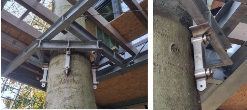
Abbildung 117: Befestigungselemente und Umreifung des Baumes unterhalb der Terrasse (links) sowie zur Realisierung einer Konsole am Baum (rechts).
