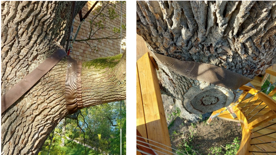
Abbildung 60: Einsatz textiler Schlingen an Astgabeln (links), welche auch im Falle des Astabwurfs u.U. noch nutzbar sind (rechts).
