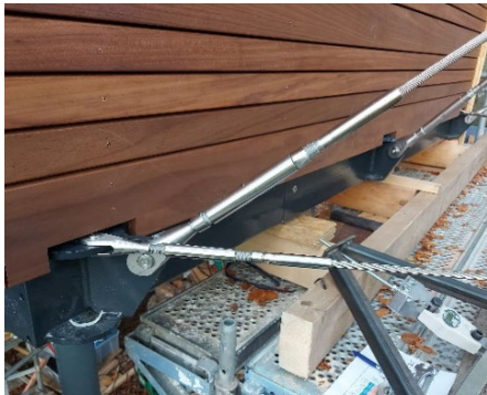
Abbildung 114: Anschluss der Seile über Spannschloss und Gabel am Wohnkörper (links) sowie am Baum (rechts).
