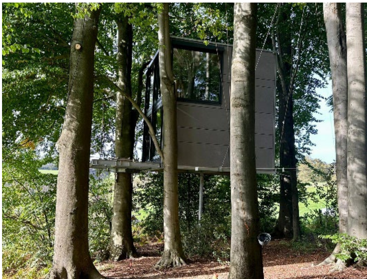
Abbildung 116: Ansicht des Bauwerks Cube.
