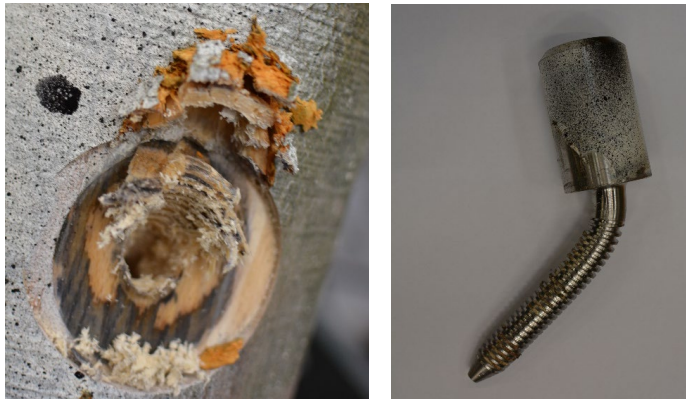
Abbildung 83: Schädigung der Holzmatrix (links) und bleibende Verformung der Baumschraube (rechts) nach der reinen Querbeanspruchung.
