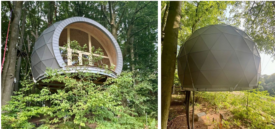
Abbildung 119: Ansicht des Bauwerks Echo.
