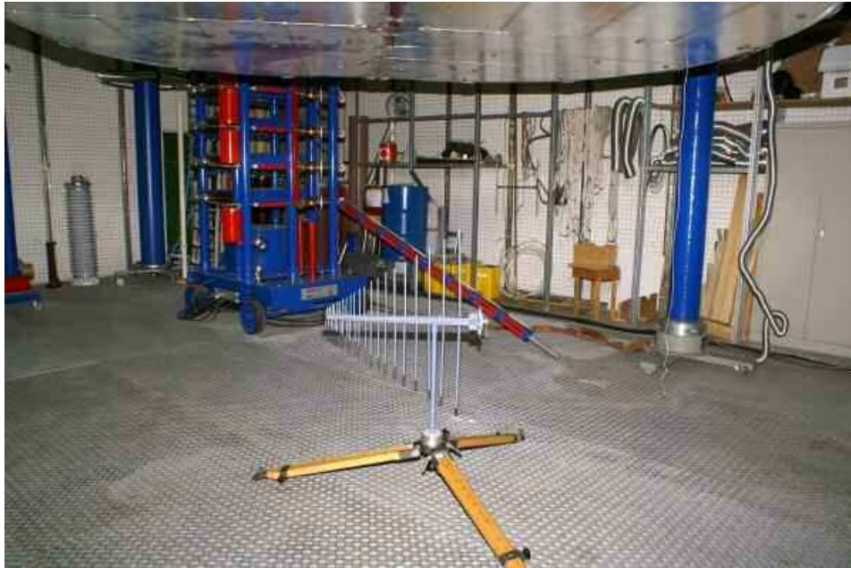
Abbildung 3.16: Vertikal polarisierte, logarithmisch-periodische Antenne auf einer Höhe von 85 cm unter der Elektrode des Hochspannungsaufbaus aus Abbildung 3.15.
