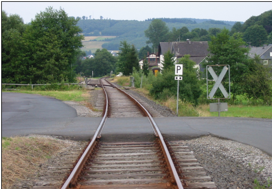
Abb. 29: Lage der Johannlandbahn im Werthenbachtal bei Helgersdorf
