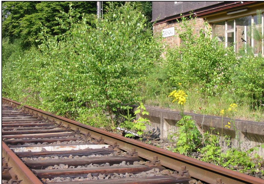
Abb. 27: Noch vorhandene Bahnsteigkante in Grensau Bf
