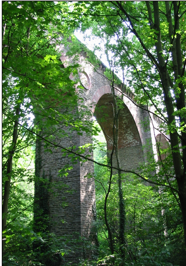
Abb. 24: Viadukt über den Brexbach bei Bendorf-Sayn am Strecken-km 4,4
