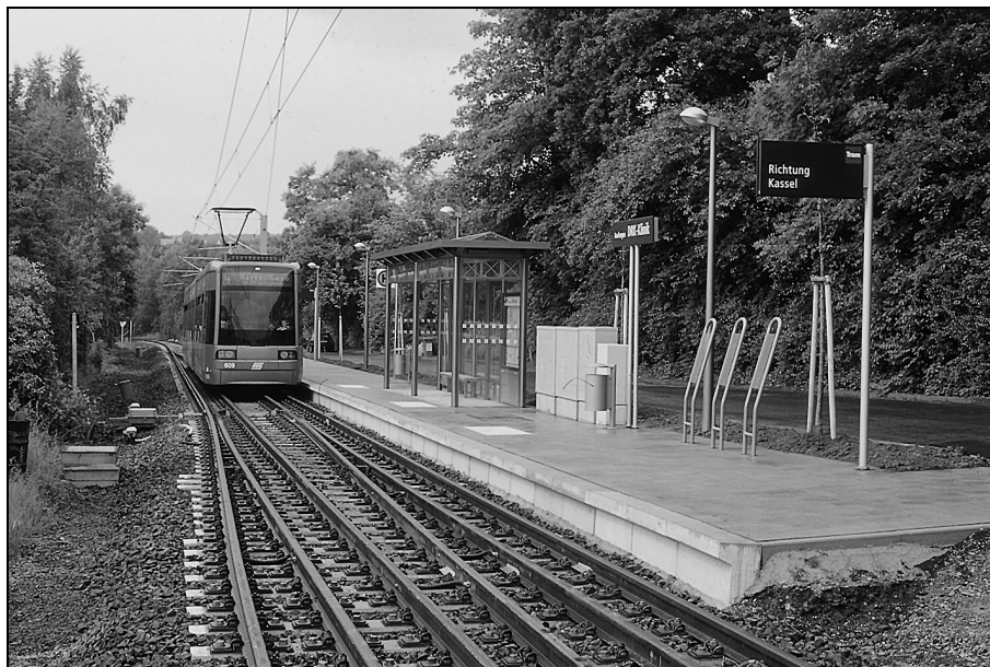
Abb. 11: Vier-Schienen-Gleis und Weichenverbindung an einem Haltepunkt des Kasseler Netzes
