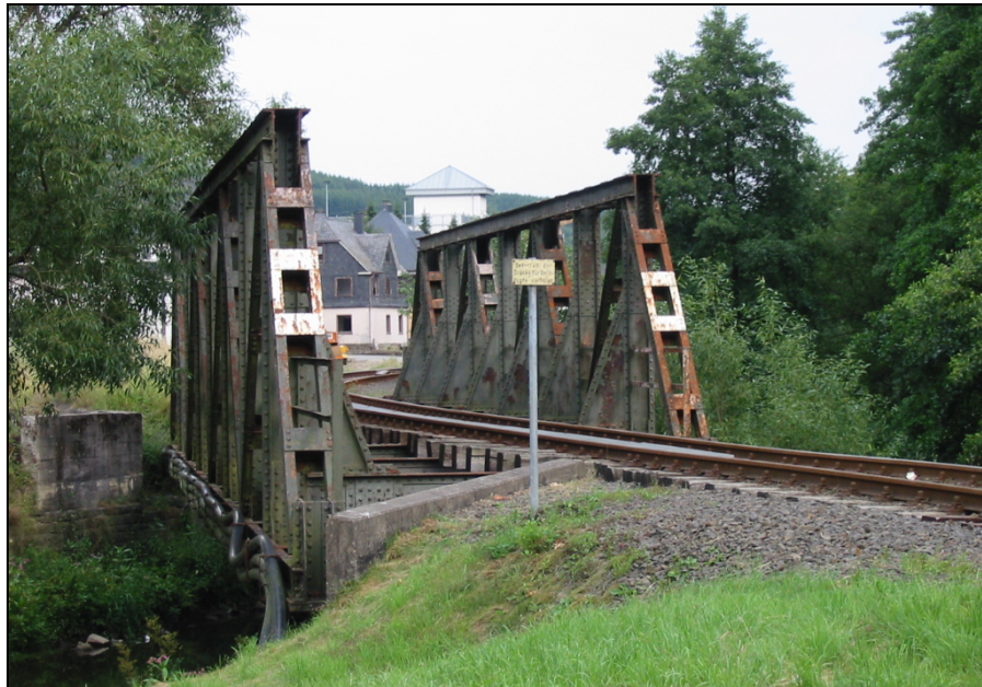
Abb. 31: Die westliche der beiden Siegbrücken nahe der Netphener Ortsmitte
