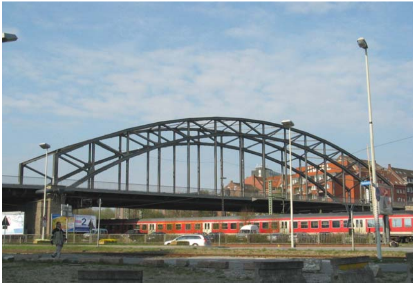
Abb.27: Gablenzbrücke in Kiel
