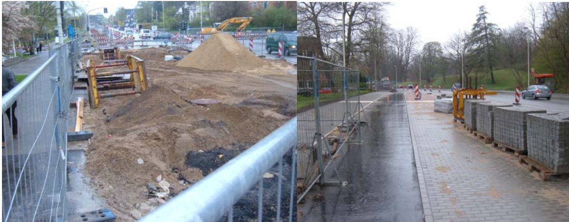
Abb.22 &amp; 23: Baumaßnahmen am Düsternbrooker Weg
