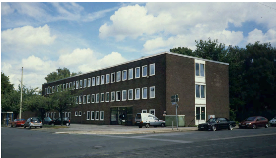
Abb. 3 – Verwaltungsgebäude Veruschacht (Foto des Verfassers 2004)
