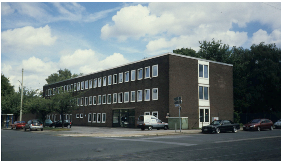
Abb. 3 – Verwaltungsgebäude Veruschacht (Foto des Verfassers 2004)
