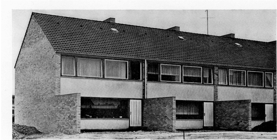
Abb. 4 – Wohnhauszeile Am Zeißbogen (Rückseite) kurz nach der Fertigstellung (Die Baubude., Heft 70, April 1972)
