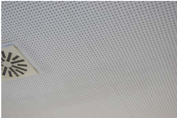
Foto 1: Schalldecke in Schule 3
