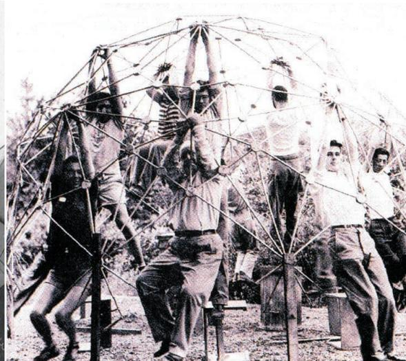
In den 40er Jahren dieses Jahrhunderts entwickelte der deutsche Architekt Konrad Wachsmann unterschiedliche Konstruktionen mit alternativen Verbindungen. Drei dieser Tragwerke haben Steckverbindungen. Konrad Wachsmann versuchte aus theoretischen Überlegungen zu verbindende Teile zu vereinheitlichen. Ungelernte Arbeiter sollten in kurzer Zeit Tragkonstruktionen verwechslungssicher errichten können. Alle Bauelemente sollten durch automatische Massenproduktion hergestellt werden.
