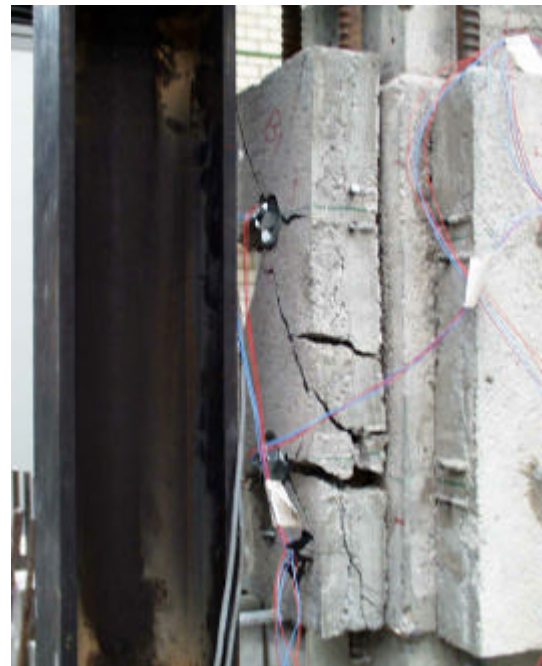
Abb. 8.43 : Versagen der Verstärkungsschicht
