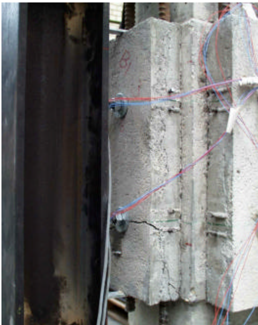
Abb. 8.42 : Ungerissener oberer Dübelbereich
