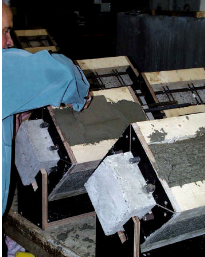
Abb. 8.11 : Schalung und Betonierichtung der Verstärkungsschichten
