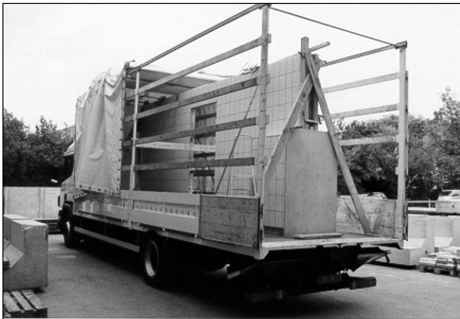
Abbildung 101: Transport vorgefertigtes Ständerwerkwandelement zur Baustelle 90
