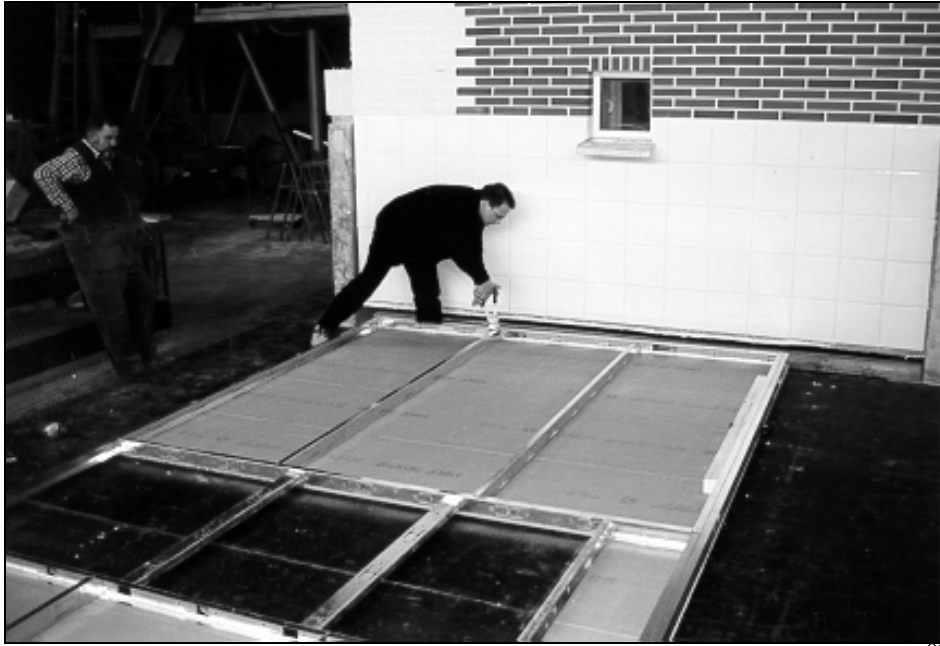
Abbildung 100: Versuchs-Vorfertigung Ständerwerkwand 89
