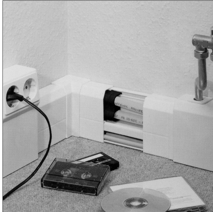
Abbildung 43: Leitungsverlegung in der Fußleiste 76
