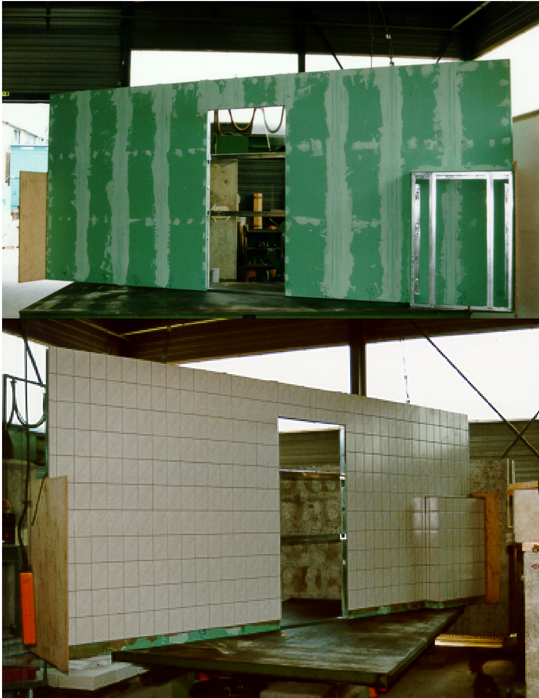
Abbildung 17: Vorgefertigte Metallständerwerkwand 51
