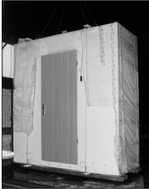
Abbildung 102: Vorgefertigte Sanitärzelle aus Trockenbauwänden 91
