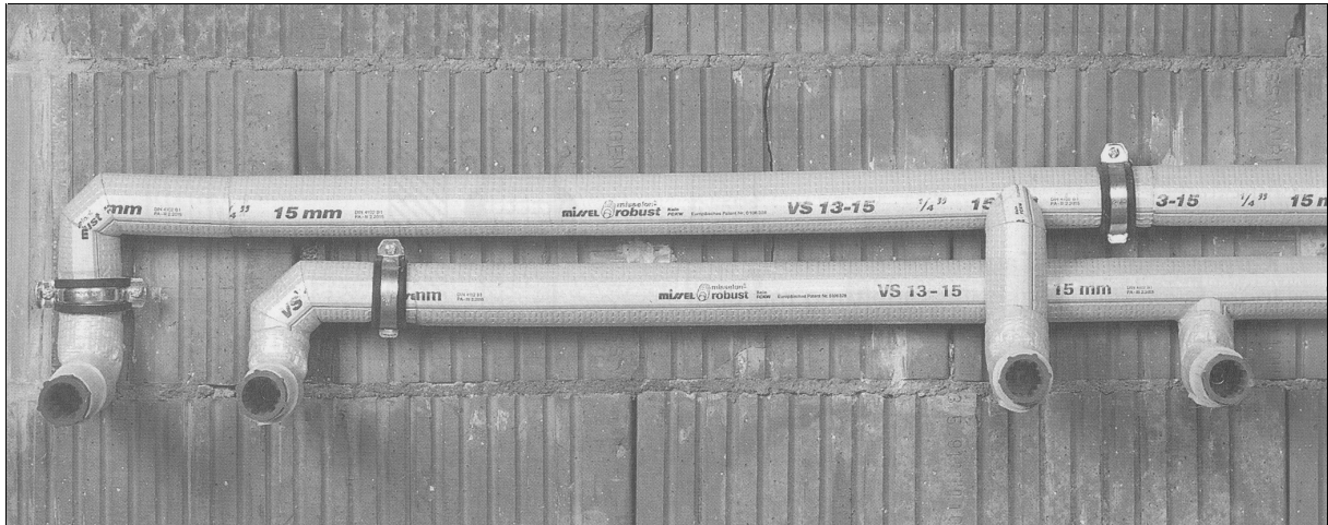
Abbildung 44: Körperschallentkoppelte und -gedämmte Wasserinstallation 77
