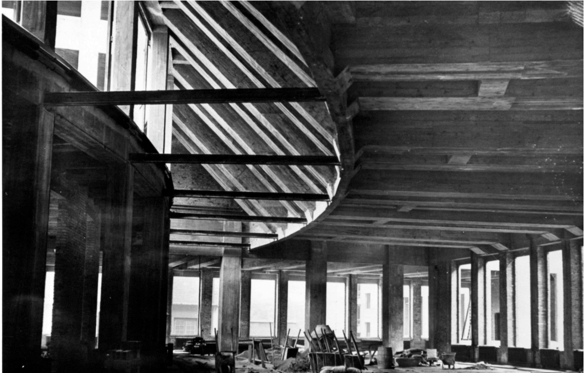
– Reichsbankerweiterung Berlin, Hängewerk über der Kassenhalle II, Stahlskelett mit Beton ummantelt, um 1937
